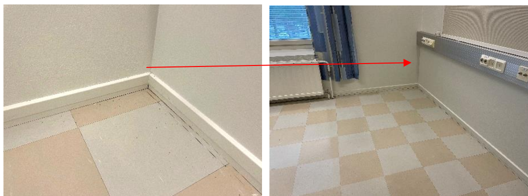
Bild 2. Markering 1. Mögelhunden markerade i kontorsutrymmet 123 konstruktionsfogen vid golvet.
