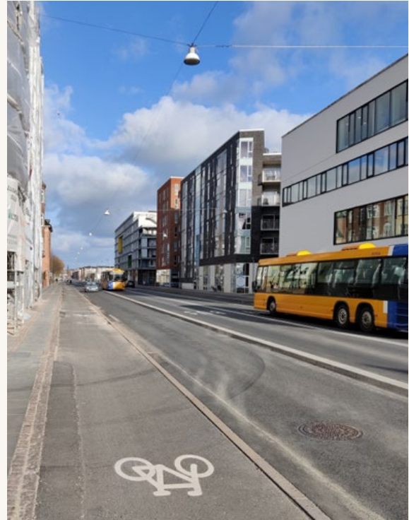
KUVA 5. Metrobussireitin varren rakennettua katuosuutta, jossa bussit (ennen linjakkaiden ja pitkien metrobussin käyttöönottoa) kulkevat ajoradan korotetuilla sisäkaistoilla. Kuva keväältä 2022.
