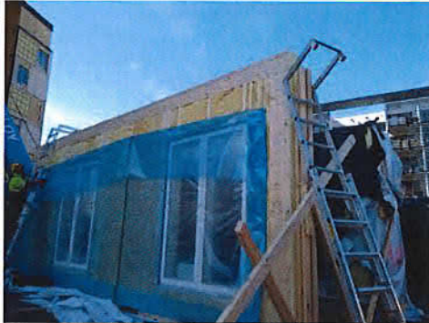
Kuva 1. Lämmöneristeitä ei asenneta ennen kuin vesikatto on vedenpitävä.
