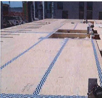
Kuva 2. Välipohjan teippaus. Välipohjien teippauksella estetään sadeveden kulkurakenteisiin ja alempiin kerroksiin.
