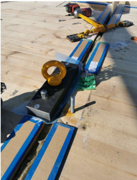
Kuva 18. Vaihtoehtoiset nosto-osat tilaelementin päältä nostamiseen
