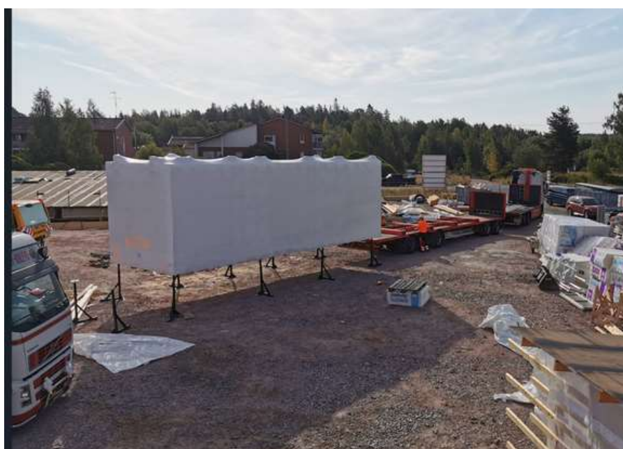
Kuva 14. Elementtien väliaikaisvarastointi
