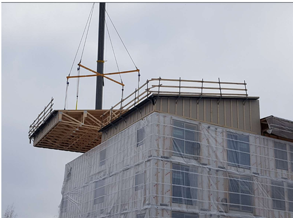
Kuva 13. Katon asennus
