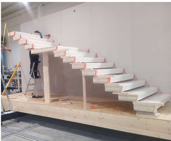
Kuva 15. Porrashuoneen mitoitus ja tuotantokuva pitkästä moduulista
