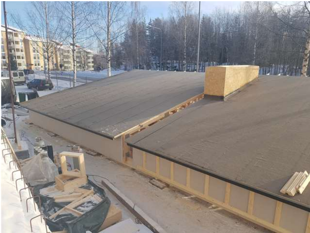
Kuva 12. Kattolohkot rakennettuna maassa
