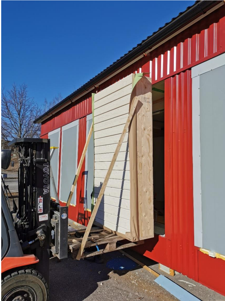
Kuva 13. Tutkimuselementin asentaminen koerakennuksen tutkimusaukkoon.
