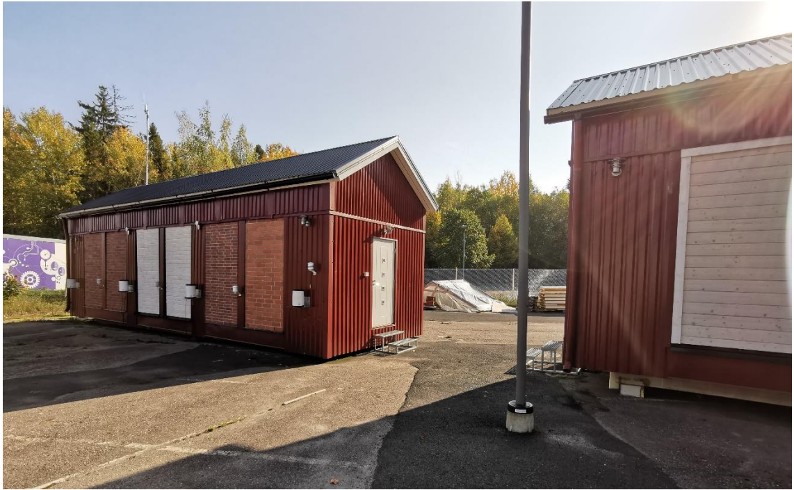
Kuva 16. Koerakennukset kuvattuna rakennusten pohjoispuolelta.
