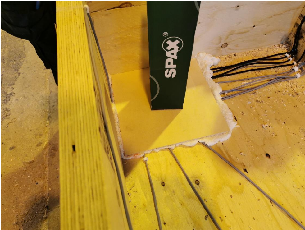
Kuva 15. ECOSAFE-elementin johtoläpiviennin tiivistys uretaanivaahdolla ja vanerikappaleella.
