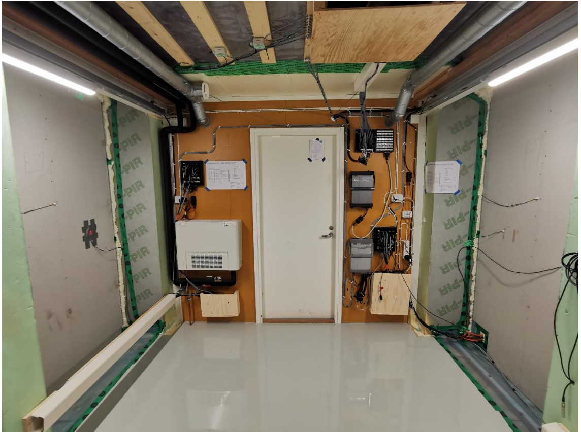
Kuva 17. Näkymä koerakennuksen tutkimushuoneesta, missä mittauksessa on kaksi kipsilevyypintaista koe-elementtiä.
