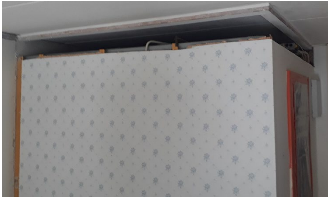
Kasettikylpyhuoneen tiivistys diffuusioavoimella höyrynsulkukalvolla
