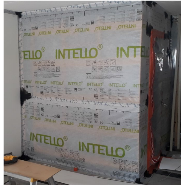
Kasettikylpyhuoneen tiivistys diffuusioavoimella höyrynsulkukalvolla
