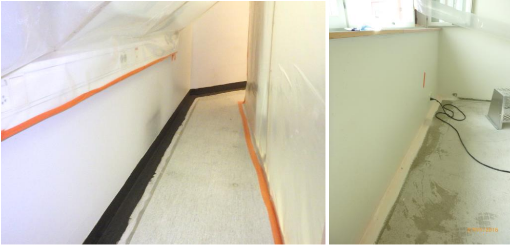
Kuva 9. Esimerkkejä pintarakenteisiin liittyvistä korjauksista radonin torjumiseksi: korjaustaso B, tiiviyden tavoitetaso 2, käyttöikätaavoite > 25 vuotta. (kuvat Vahanen Rakennusfysiikka Oy:n arkisto)
