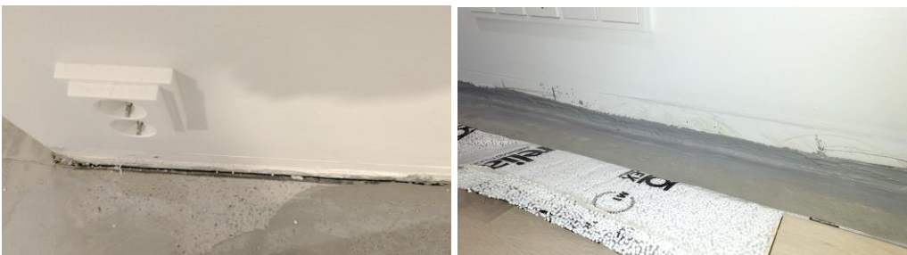
Kuva 10. Esimerkki korjaustasosta B, tiiviyden tavoitetaso 2. Maanvaraisen betonilaatan ilmatiivyyttä parannettiin siveltävällä tiivistysmassalla. (kuvat Vahanen Rakennusfysiikka Oy:n arkisto)
