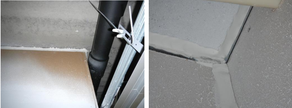
Kuva 1. Esimerkki toimistorakennuksesta, jossa puutteet tilojen ilmaääneneristävyydessä olivat lähtökohta ilmatiivyyden parantamiselle. (kuvat Vahanen Rakennusfysiikka Oy:n arkisto)
