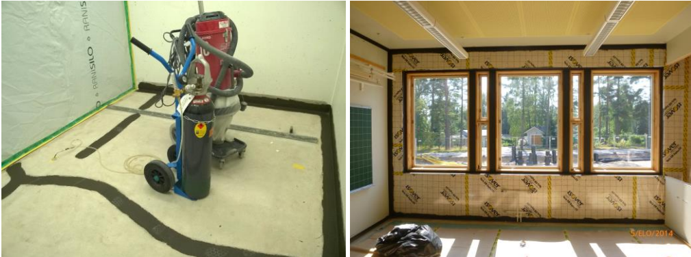
Kuva 11. Esimerkki pintarakenteiden alle tehdyistä tiivistyksestä: korjaustason A, tiiviyden laatutaso 2, käyttöikätaivoite > 25 vuotta. (kuvat Vahanen Rakennusfysiikka Oy:n arkisto)
