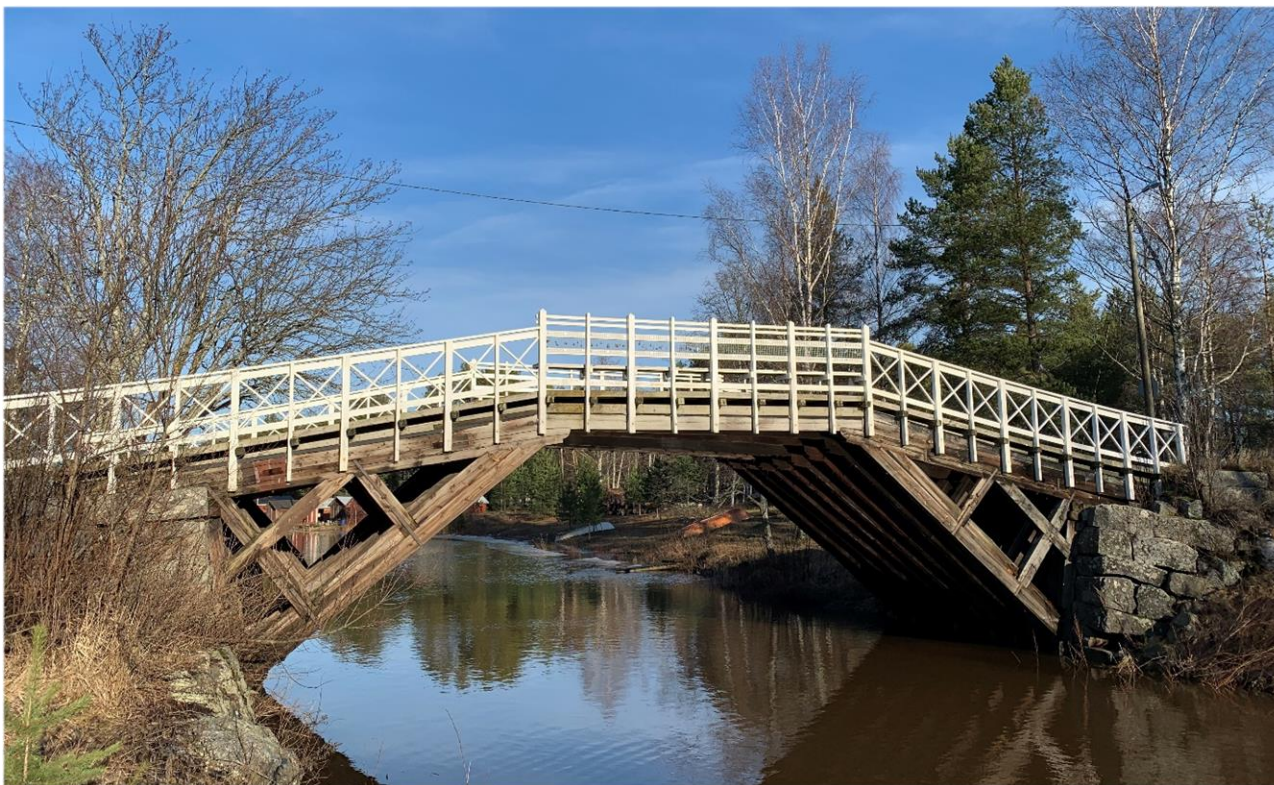
Kuva 6. Vuonna 1907 Kokkolan kaupunginsalmeen rakennettu hirsi- ja kivirakenteinen silta, ns. punainen silta . Inventoimaton kohde. Kuva Jouni Mustonen 2020.
