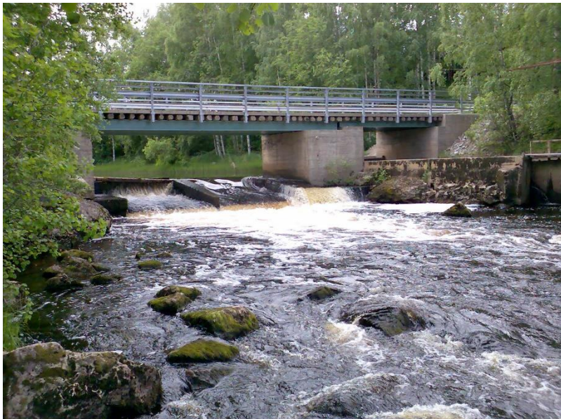
Lestijoen pääuomassa sijaitseva Parkikosken vanha vesivoimalaitospato. Kuva Etelä-Pohjanmaan ELY-keskus
