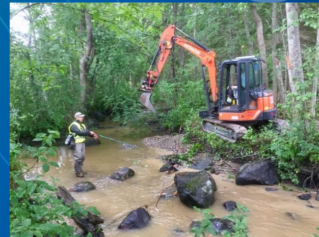
Virtaveden rakenteellista kunnostamista mm. kiviä ja soraikkoja palauttamalla. Kuva virho.fi
