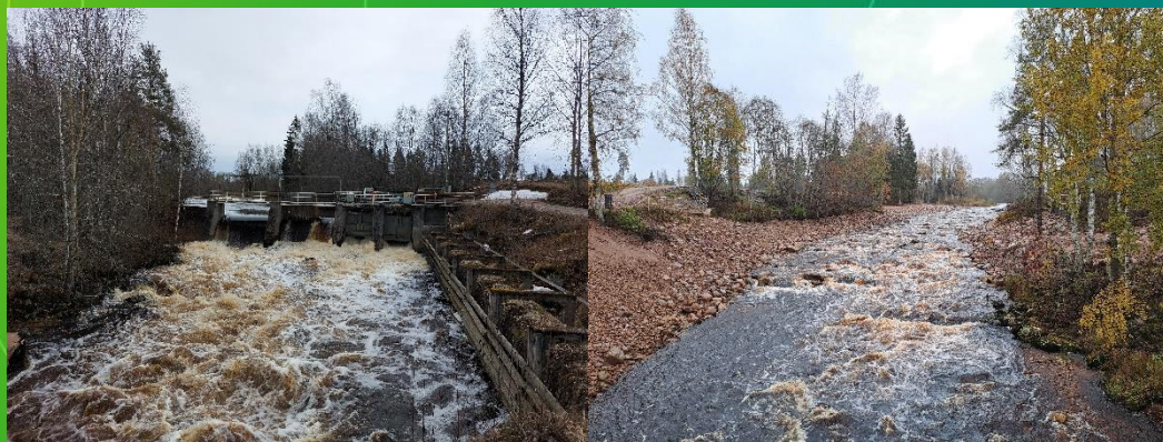
Jyllinkosken vesivoimapato ennen ja jälkeen purkamisen, Karvianjoki. Kuva Perttu Tamminen, MMM
