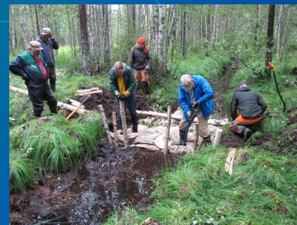
Valuma-alueen kunnostamista metsäoja tukkimalla alueen hydrologian palauttamiseksi. Kuva sll.fi
