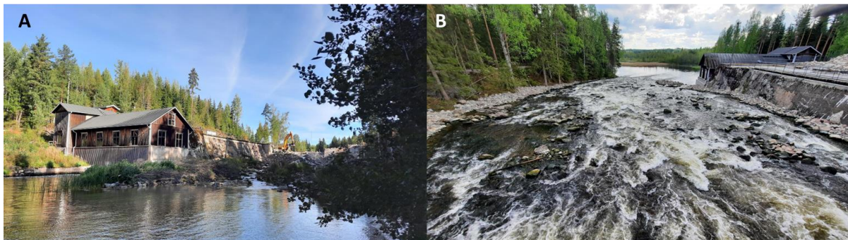
Kuva 3. Hiitolanjoen Lahnakosken pato poistettiin ja alue kunnostettiin kesällä 2023 vaelluskaloille soveltuvaksi lisääntymis- ja poikastuotantoalueeksi; A) pato on vielä paikallaan ja työt aloitettu, B) pato on poistettu ja vesi virtaa jälleen vapaasti uomassa. Kuvat: Pauliina Louhi.
