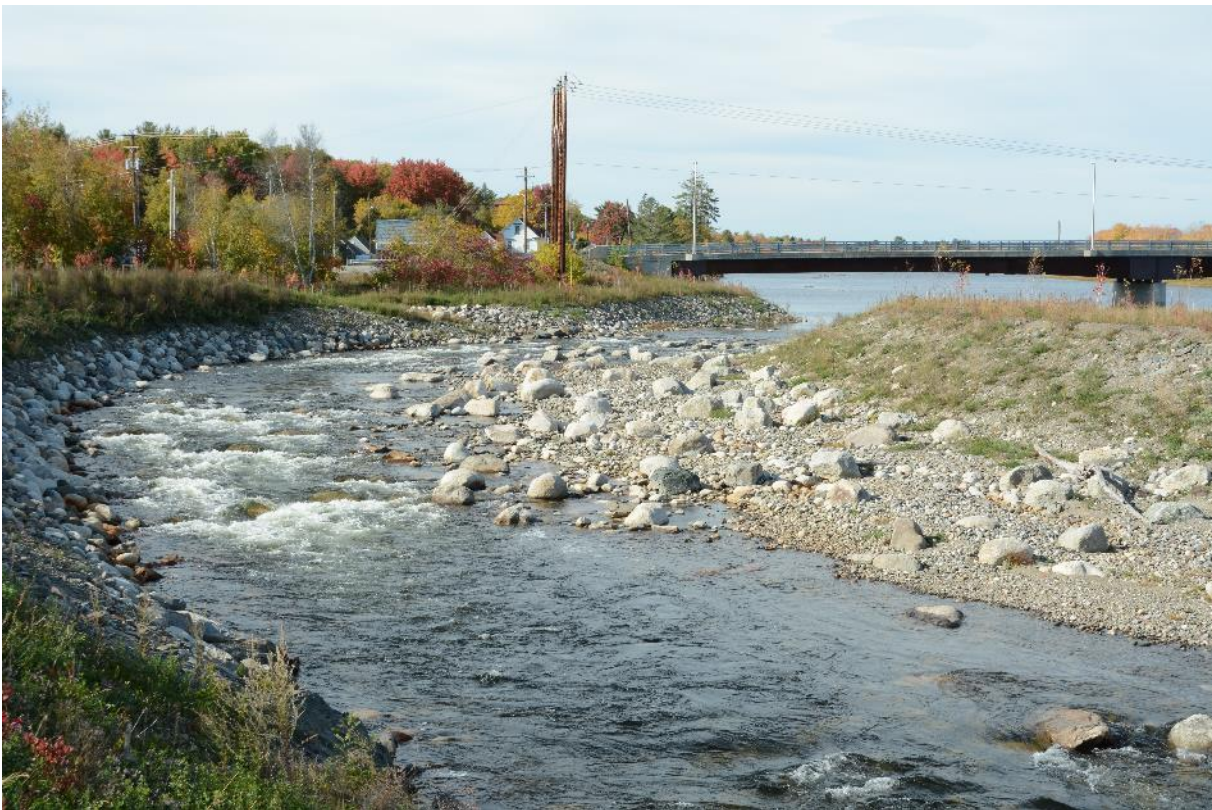
Kuva 17. Luonnonmukainen kalatie Penobscot-joen Piscataquis-sivujoessa Howlandin padon yhteydessä. Tällainen kalatie toimii niin kalojen vaellusyhteytenä kuin poikastuotantoalueenakin. Kuva: Panu Orell.
