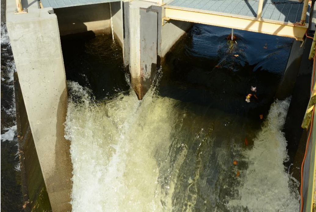
Kuva 10. Alasvaellusväylän sisäänkäynti alavirran puolelta kuvattuna. Sisäänkäynnin sijainnilla ja virtausolosuhteilla on keskeinen merkitys koko alasvaellusratkaisun toimivuudelle. Kuva: Panu Orell.
