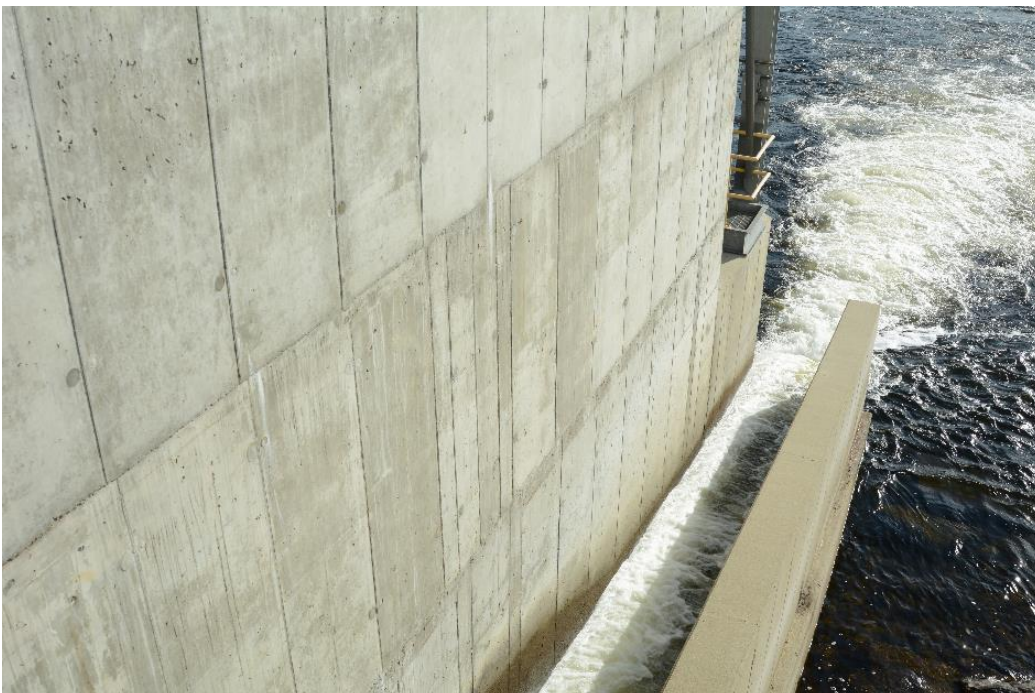
Kuva 11. Voimalaitoksen viereen rakennettu betoninen alasvaellusväylä. Kuva: Panu Orell.
