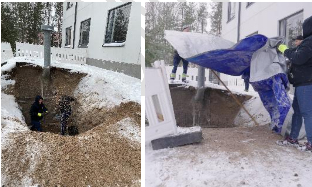
Kuva Hätäpoistumisreit in ulostuloaukko kaivetaan esiin (kuva vasemmalla) käyttöönottovaiheessa, jonka jälkeen kaivanto peitetään pressuilla ja suojataan aidoilla (kuva oikealla). (Kuvat: Sisäministeriö)
