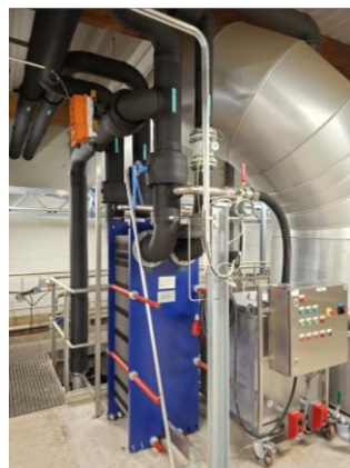
KUVA 4 TEKNISESTÄ TILASTA PROSESSIHALLIIN SIIRRETTY TALTEENOTON PÄÄLÄMMÖNVAIHDIN JA VAIHTIMEN PESUYKSIKÖ
