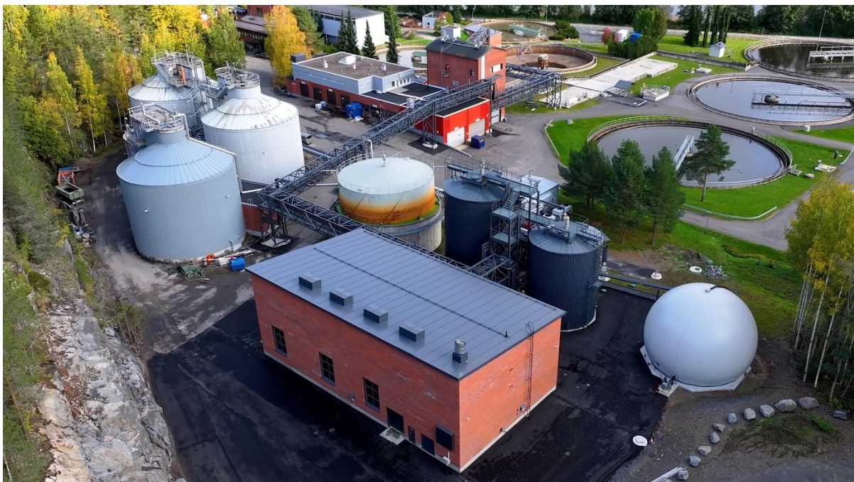
Kuva 1. Kuvassa etualalla uusi raakalietteen käsittelyrakennus, jonka takana näkyvät tumman harmaina raakalietteen varastosäiliö sekä sakeutetun lietteen varastosäiliö. Oikealla kuvassa näkyy vaalean harmaa kaasukello. Raakaliete johdetaan raakalietepumppaamolta raakalietteen sakeutukseen kuvassa näkyvää ristikkorakenteista putkisiltaa pitkin.
