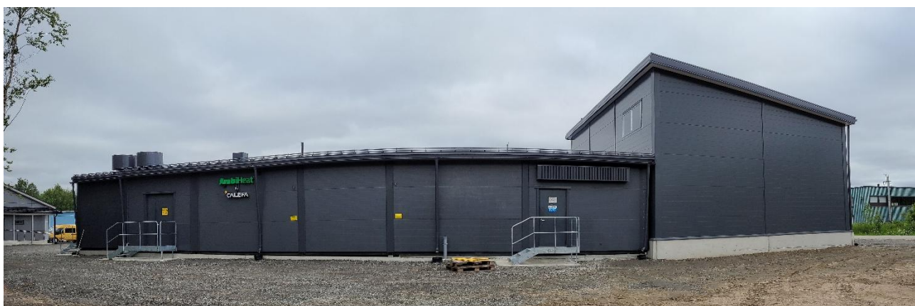
Kuva 3: Rakennus- ja asennustyöt valmiina käyttöönoton alussa heinäkuussa 2025
