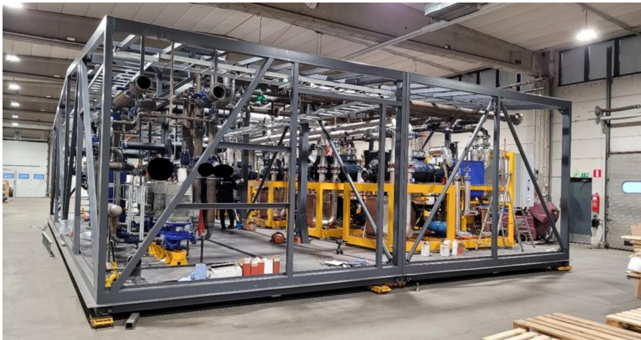
Kuva 2: Lämpöpumppulaitoksen kokoonpanoa ja putkistoasennuksia käynnissä Calefan tehtaalla lokakuussa 2024.
