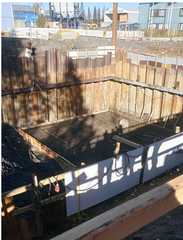
Kuva 1: Pumppaamo-osan pohjalaatan raudoitus syyskuussa 2024.
