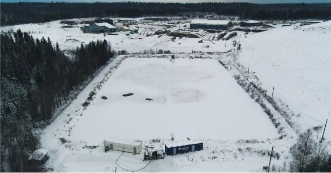
Kuva 3 Ilmakuva Jättekukon tasausaltaasta ja pilotointikonteista. Nykyisin kenttä- ja suotovesistä koostuva tasausaltaan vesi pumpataan pumppauskaivon kautta Kuopion veden operoimalle kunnalliselle jäteveden puhdistamolle.
