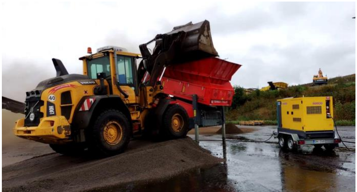
Kuva 7. Mobiiliseulan syöttö rampilla korotetulla pyöräkoneella. Kuva Niko Kytölä.
