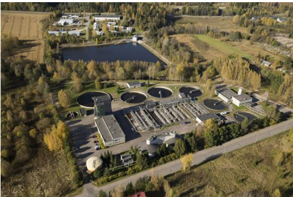
Kuva 1. Ilmakuva Lahti Aqua Oy:n Ali-Juhakkalan jätevedenpuhdistamosta.
