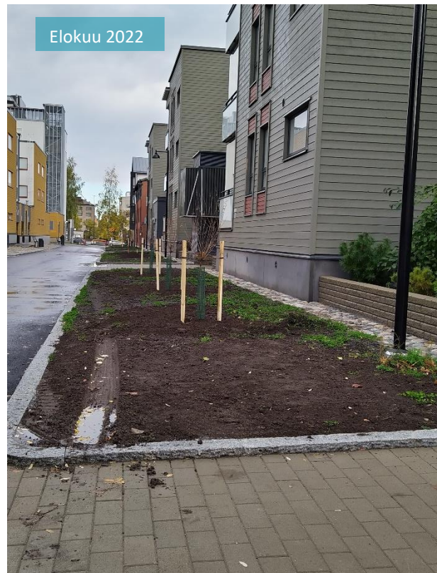
Kuva 8 Vuoden 2021 viherrakennustyömaa, jossa käytetty hankkeen multa. Multa vaikuttaa ominaisuuksiltaan tavoitteen mukaiselta - hyvin vähärikkakasviselta sekä melko hidaskasviselta. 2022
