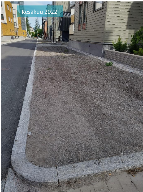
Kuva 8 Vuoden 2021 viherrakennustyömaa, jossa käytetty hankkeen multa. Multa vaikuttaa ominaisuuksiltaan tavoitteen mukaiselta - hyvin vähärikkakasviselta sekä melko hidaskasviselta. 2022
