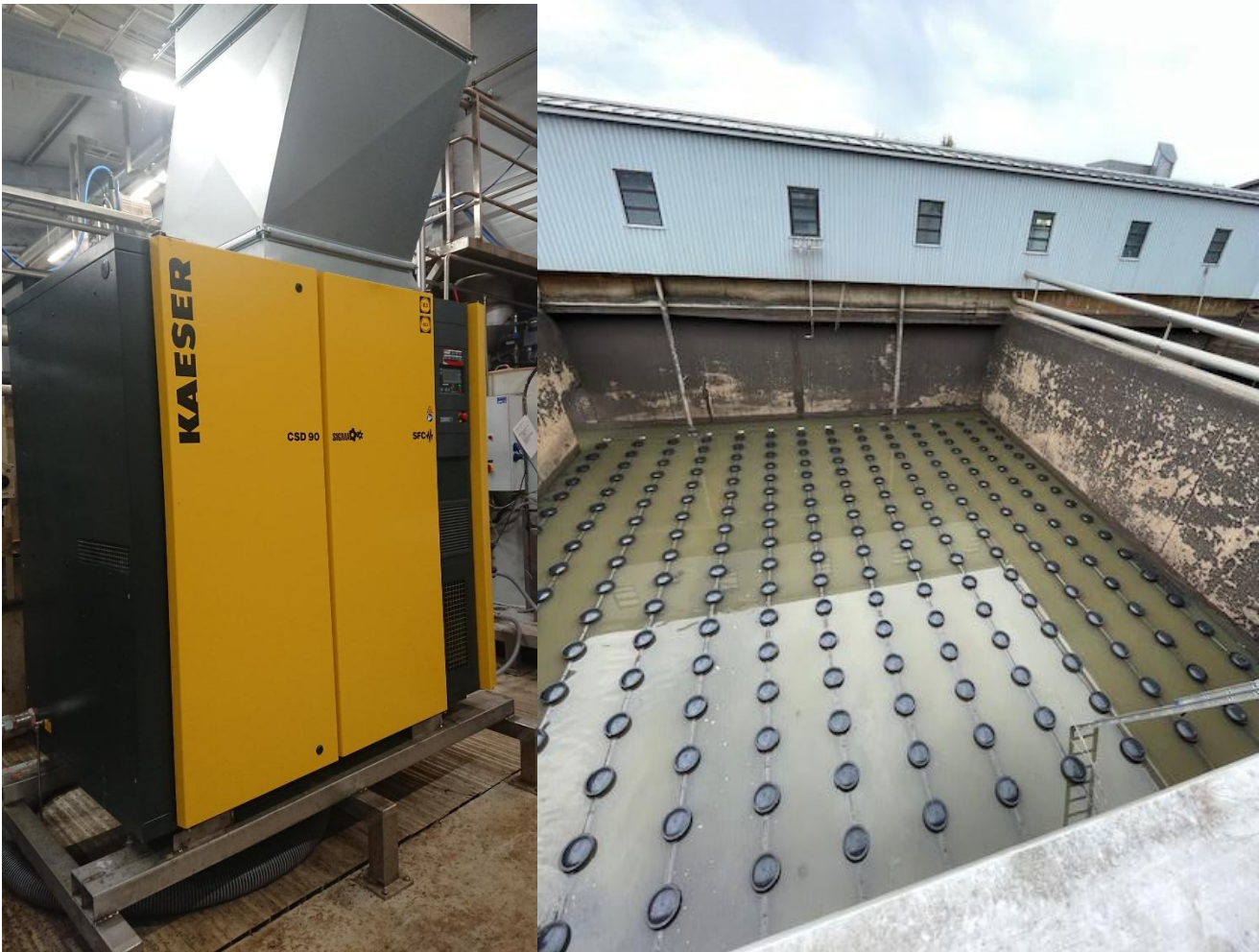
Kuva 1 Instrumenttipaineilmakompressori ja Kuva 2 Uudet ilmastinlautaset asennettuna lohkossa 1–2.
