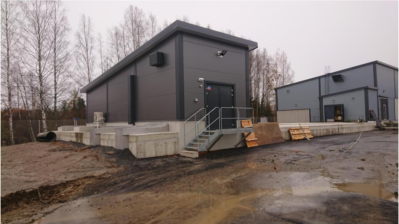
Kuva 10 Prosessivesisäiliö ja pumppaamo osa valmiina syksy 2025 suuntana kaakkoon
