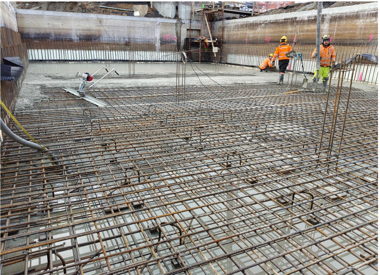
Kuva 5 Prosessivesisäilön pohjalaatan raudoitus ja valupäivä kevät 2025
