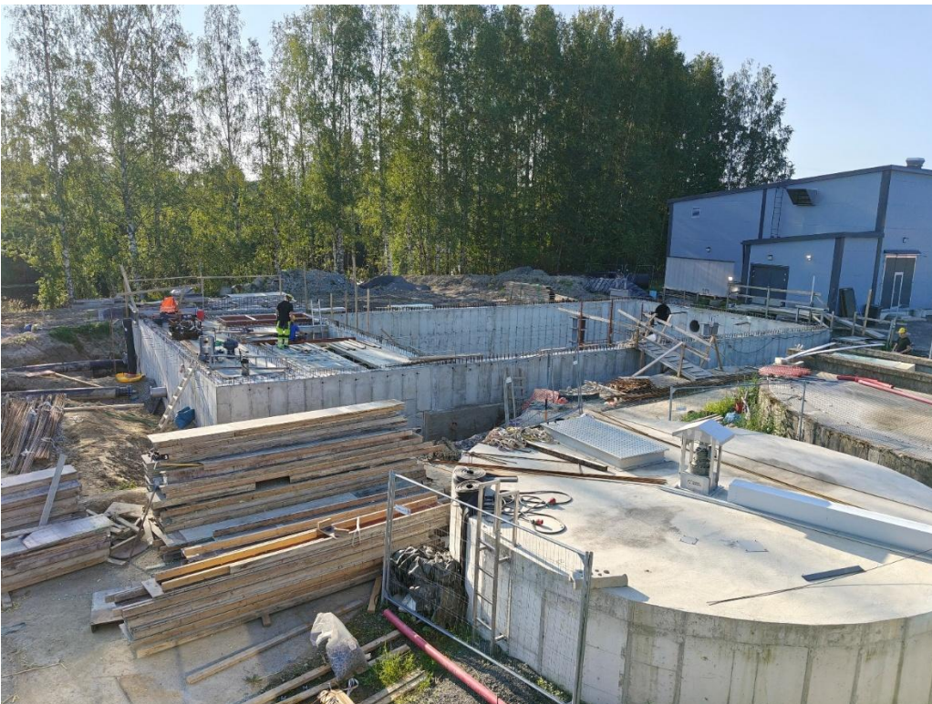
Kuva 7 Prosessivesisäiliö rakentunut maanpinnan tasolle kesä 2025
