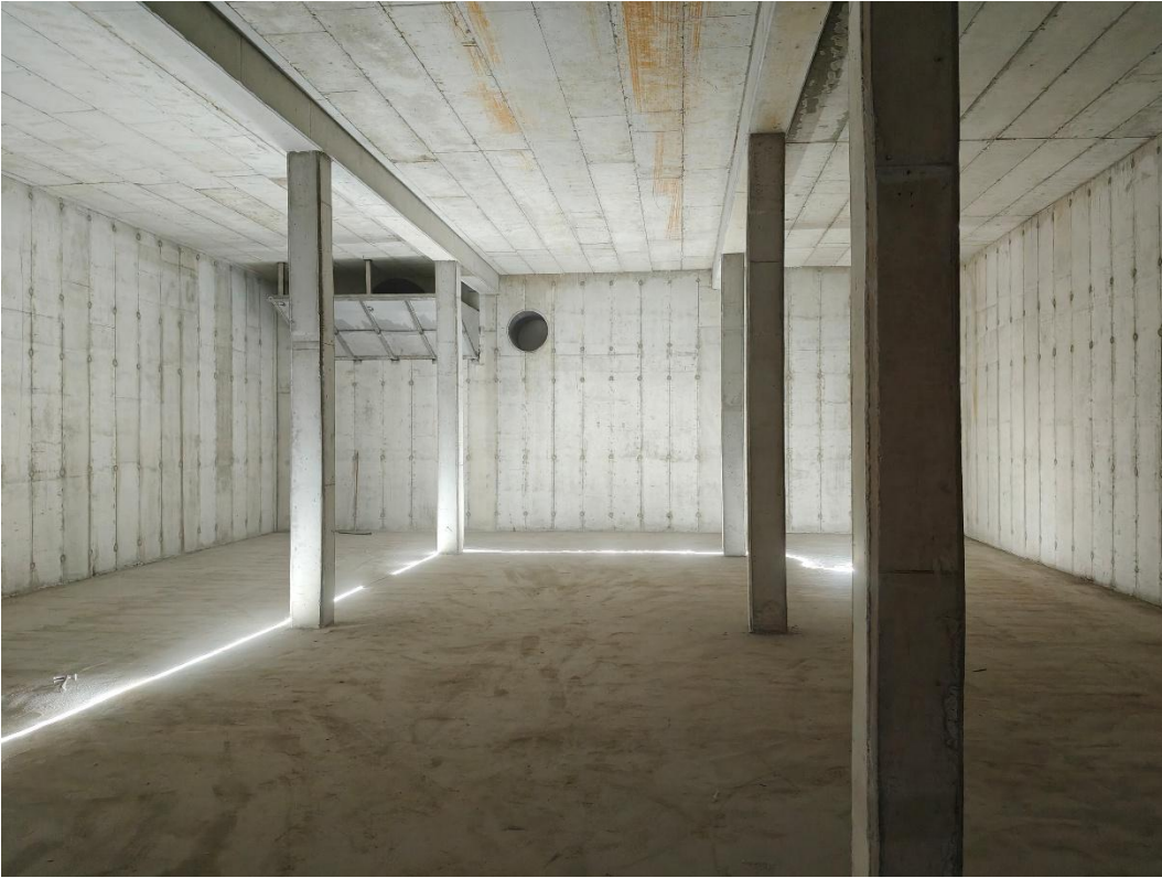
Kuva 8 Prosessivesisäiliö sisältä valmiina syksy 2025
