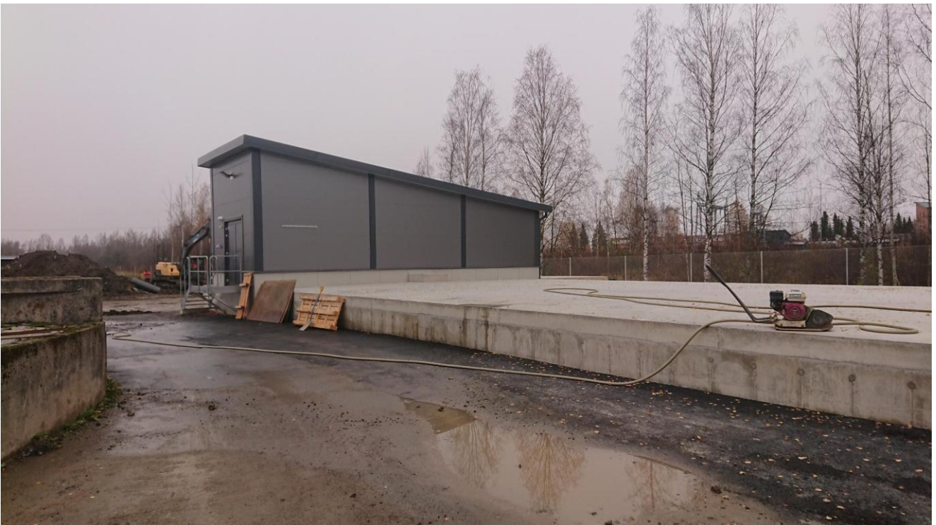
Kuva 9 Prosessivesisäiliö ja pumppaamo osa valmiina syksy 2025 pohjoiseen
