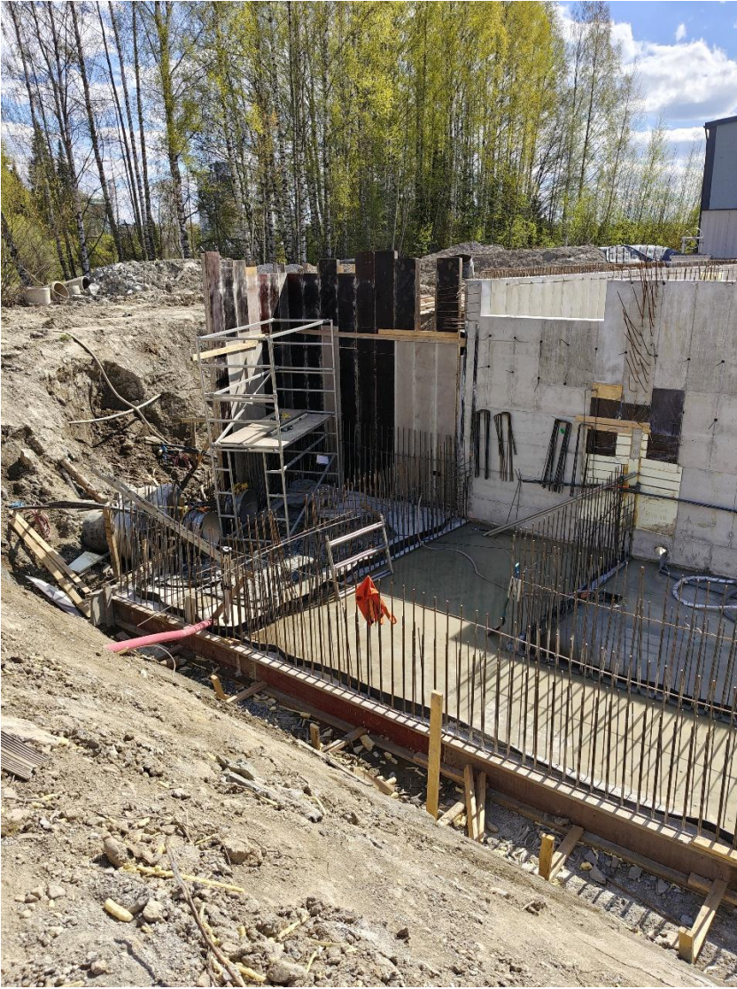
Kuva 6 Pumppaamo rakennuksen pohjalaatta kesä 2025
