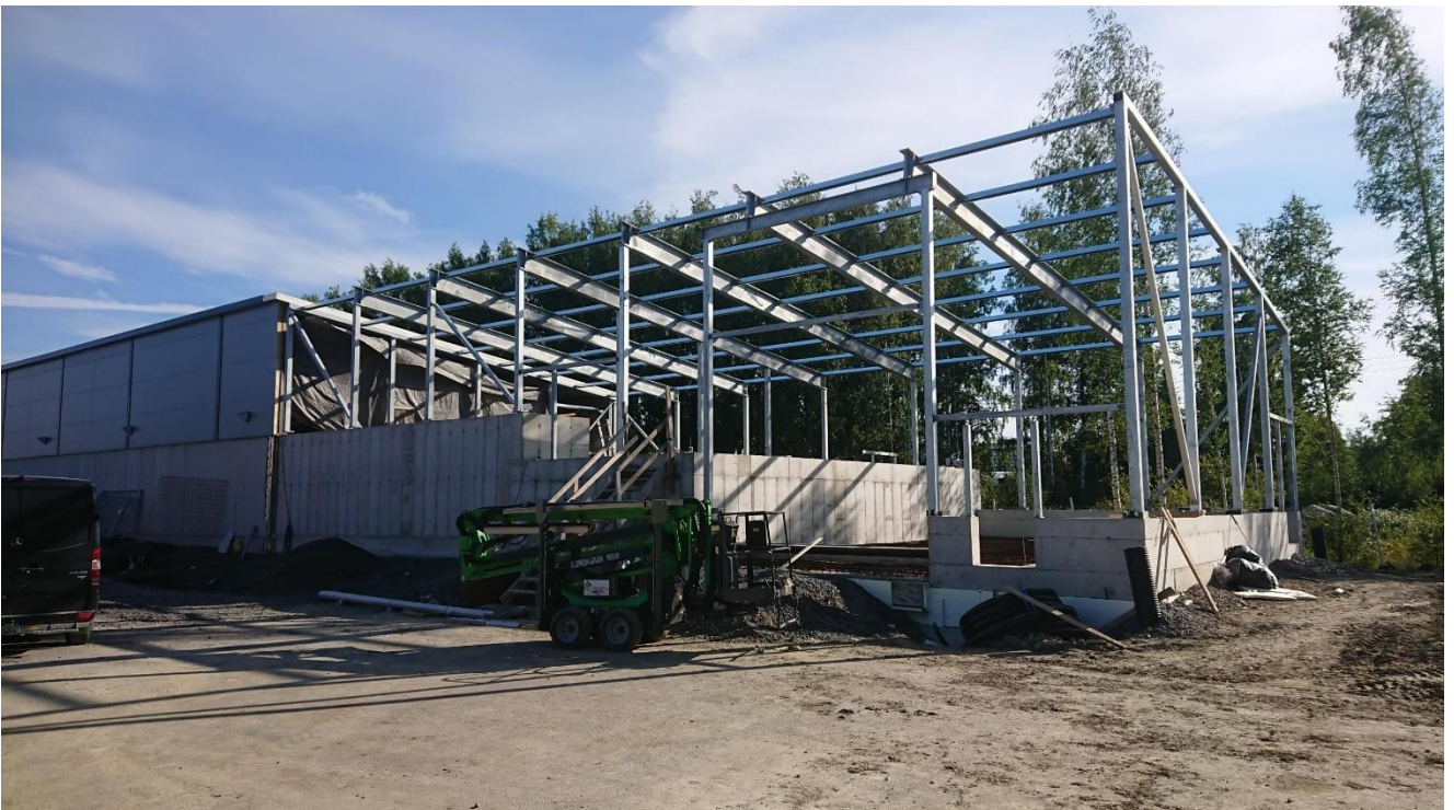
Kuva 3 Teräsrunko asennettuna elokuussa 2022.
