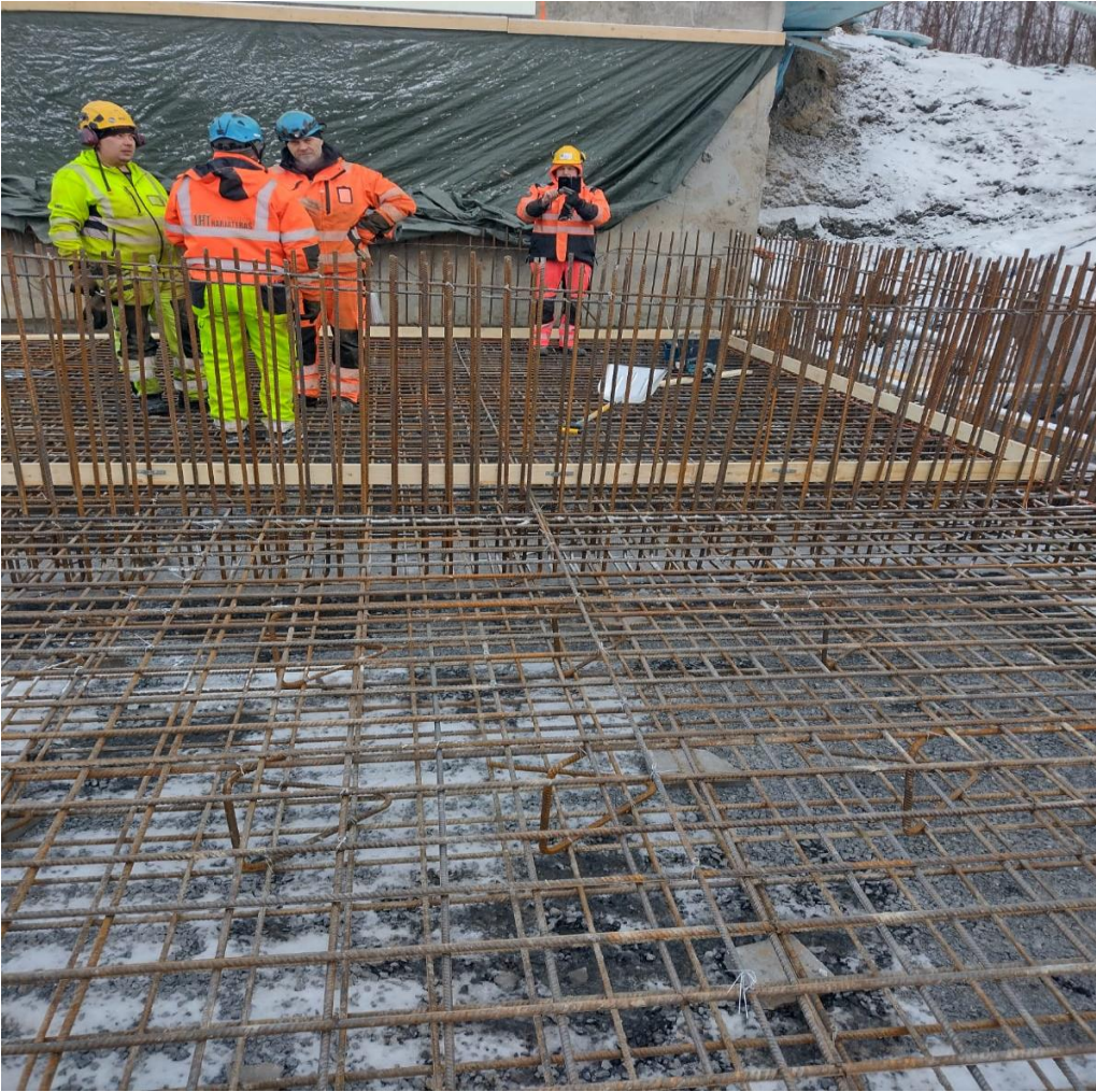
Kuva 1 Pohjalaatan raudoituksia huhtikuussa,
