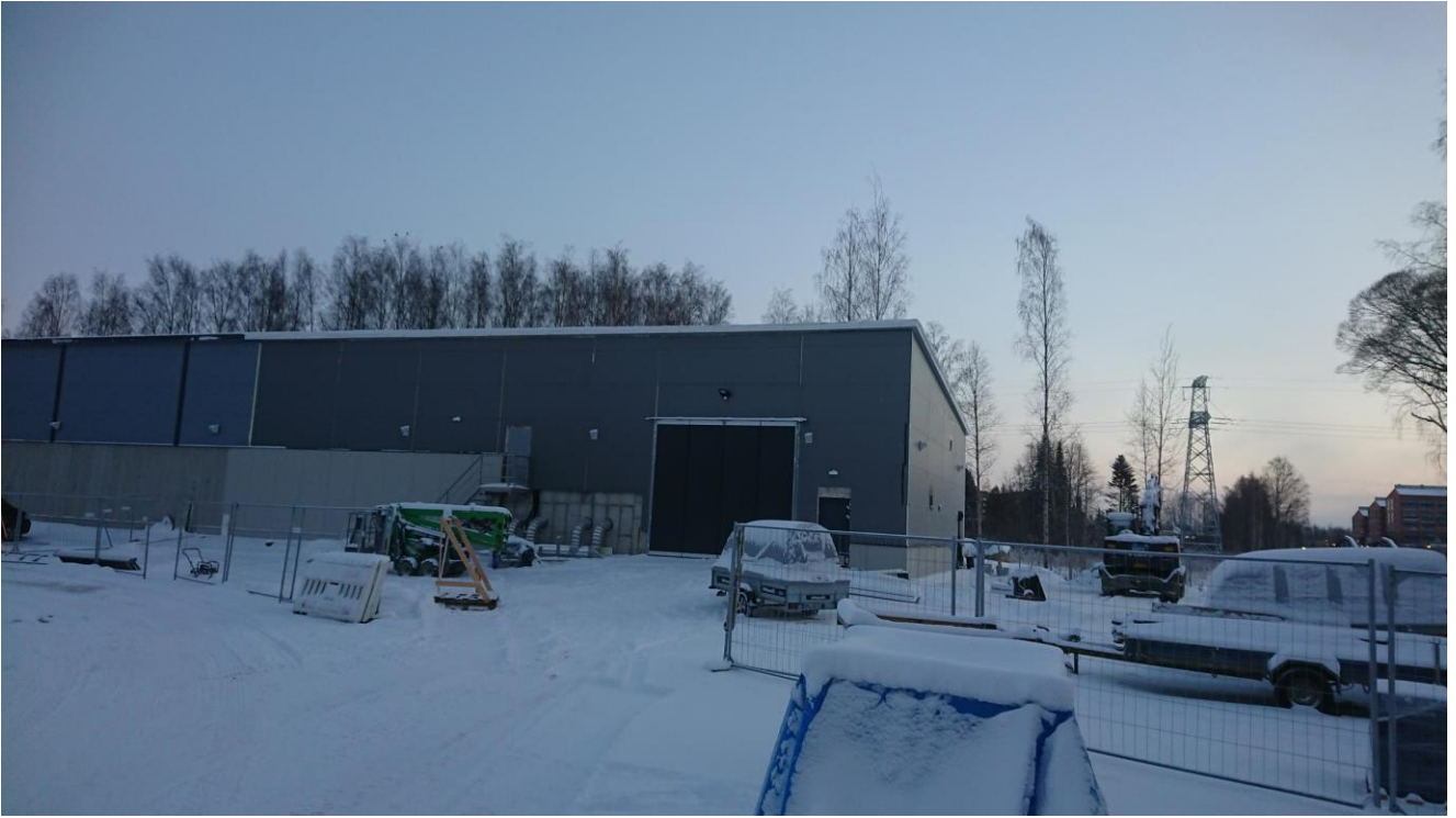
Kuva 6 Talvinen työmaa joulukuussa 2022.
