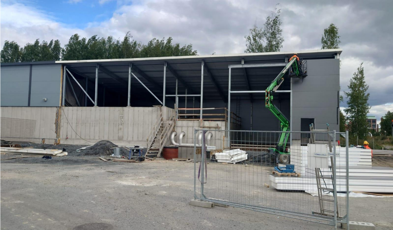
Kuva 4 Ulkoseinä elementtien asennus menossa syyskuun alussa.
