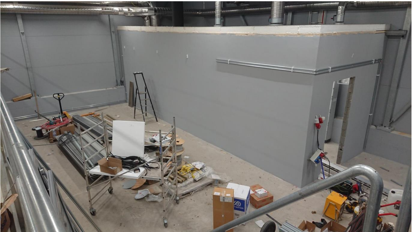
Kuva 9 Kemikaalisäiliön tila odottaa lattiaa maalausta ennen asennusta ja taustalla talotekniikan huone.
