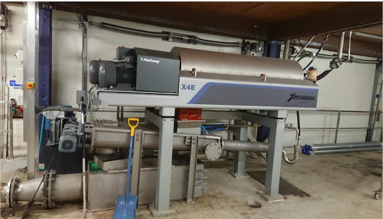
Kuva 5 Lietelinko asennettuna vanhalle puolelle.
