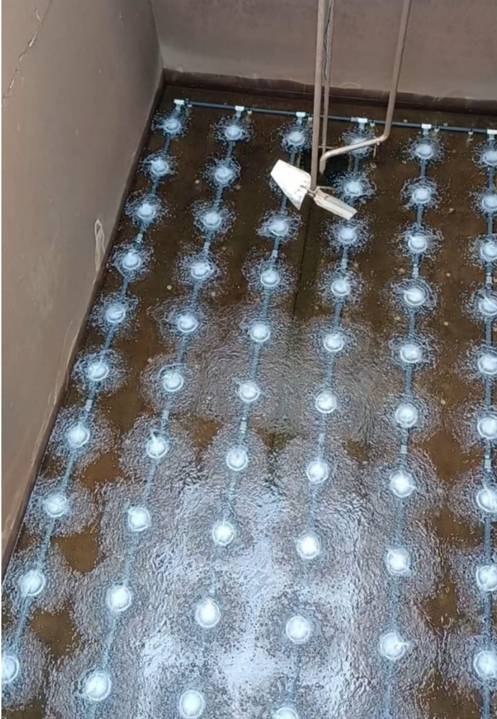
Kuva 4. Ilmastinlinja 4 ilmastimien tiiveyden tarkastus ennen käyttöönottoa.
