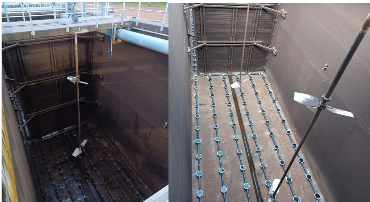
Kuva 1. Ilmastuslinjan 3 yksi lohko ennen (vasemmalla) ja jälkeen (oikealla) ilmastimien vaihtoa.
