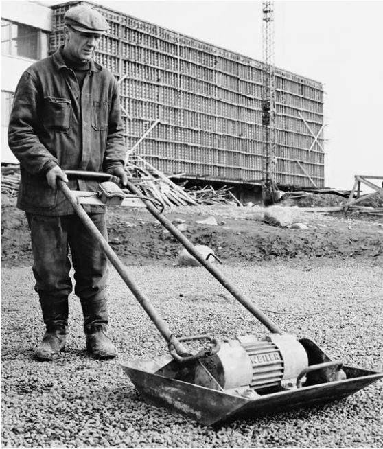
Maantiivistystä sähkökäyttöisellä tärylevyllä. (Ramirent Oyj:n kuva-arkisto)
