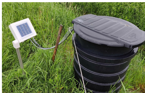
Kuva 13. Pilottikaivo ja ohjausyksikkö Nivalassa.
