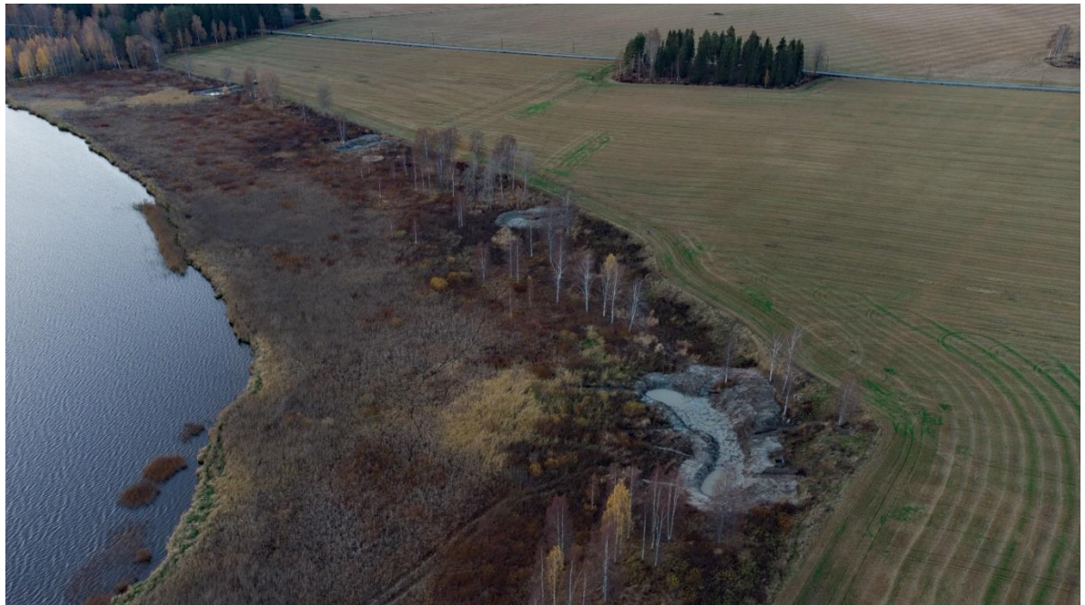
Kuva 13. Mommilanjärven rantaluhdalle perustetut laskeutusaltaat olivat valmistuttuaan ensin kuivillaan ennen syysateiden alkamista. Kuvassa altaat 2-5.
