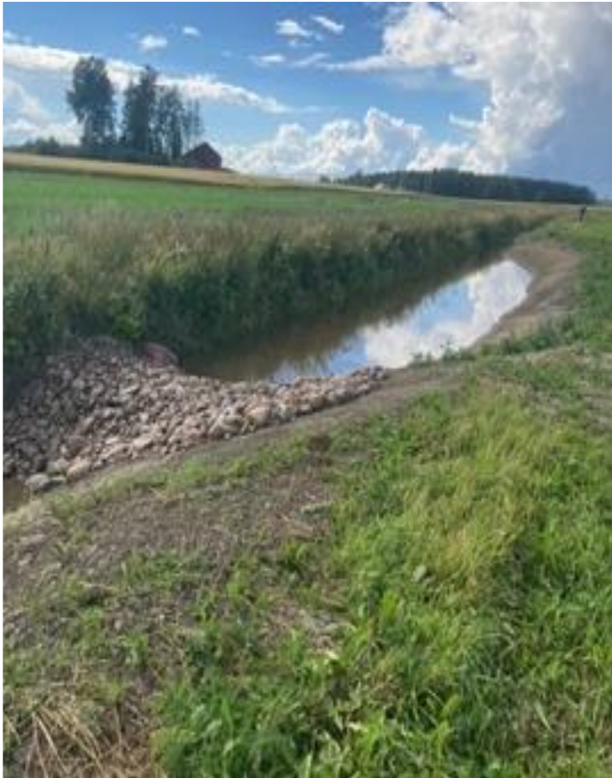
Kuva 9. Pohjapatosarjan suunnitteli vesistöasiantuntija Suvi Mäkelä ja sen toteutti viljelijä itse vuokraamallaan kaivinkoneella.
