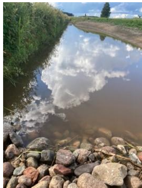
Kuva 8. Valtaojan erodoitumista ja Puujokeen kohdistuvaa kuormitusta vähentämään rakennettiin pohjapatosarja hyvässä yhteistyössä viljelijän kanssa.
