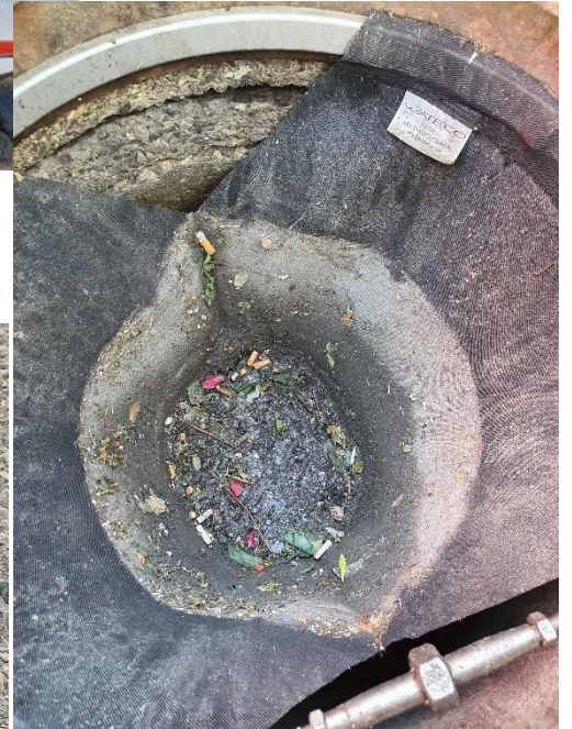
Kuva 2. Suodatin asennettuna hulevesikaivoon.
