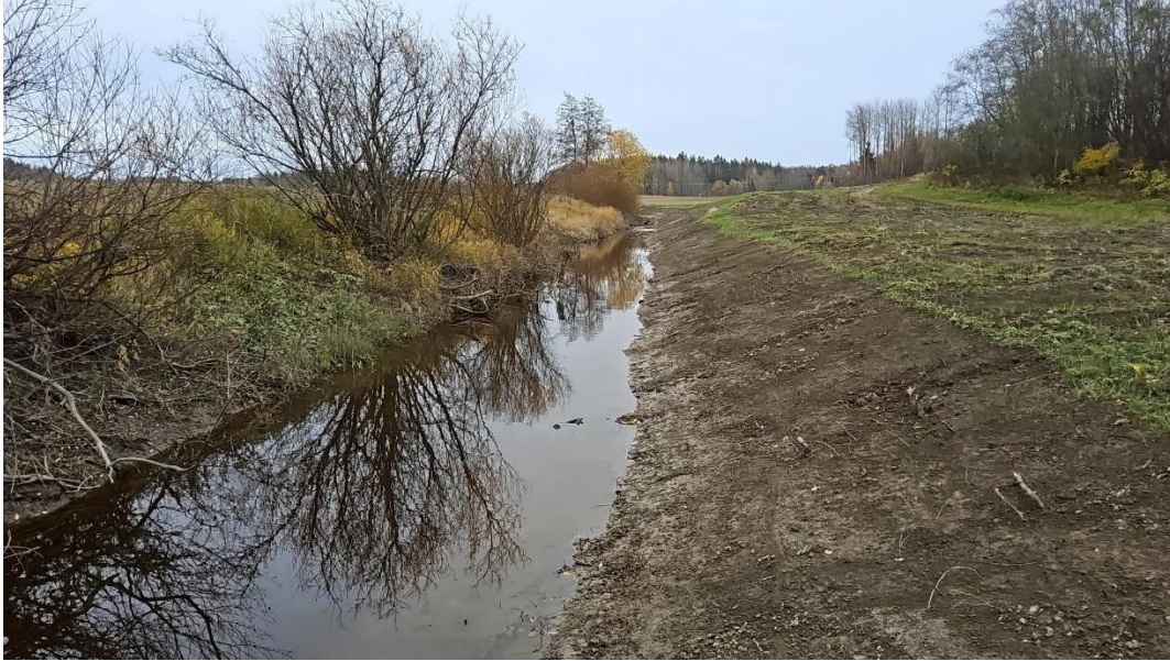
Kuva 8. Bölebäckenin kaksitasouoma toteutettiin toispuoleisena, kuva 22.10.2024
