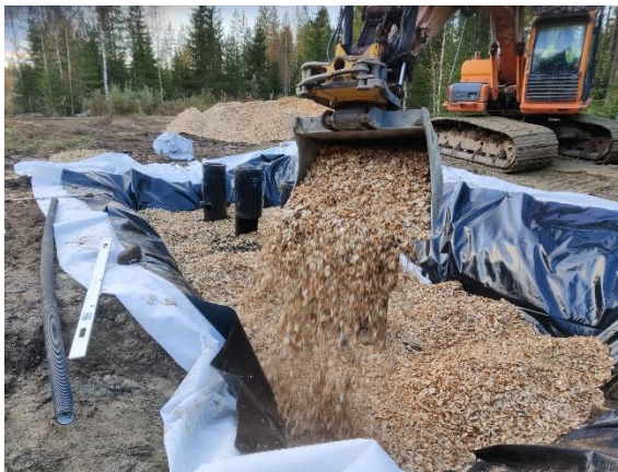
i. Haketta suodattimeksi
