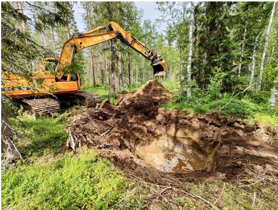
Kuva 38: Koerakenteen rakennettavuuden tutkimusta testikaivuilla ensimmäisellä sijoituspaikalla (Kuva Juha-Pekka Saarelainen)
