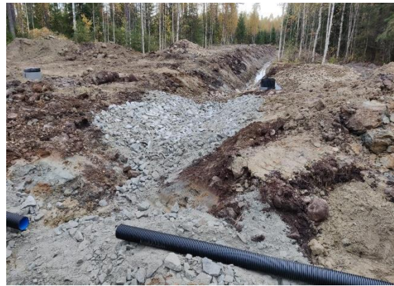
t. Ylivirtaamoojan eroosiosuojaus murskeella
