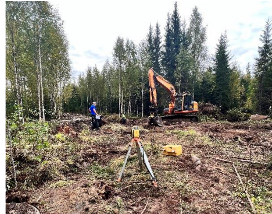
d. Reaktoriyömaan vaaitus tasolaserilla
