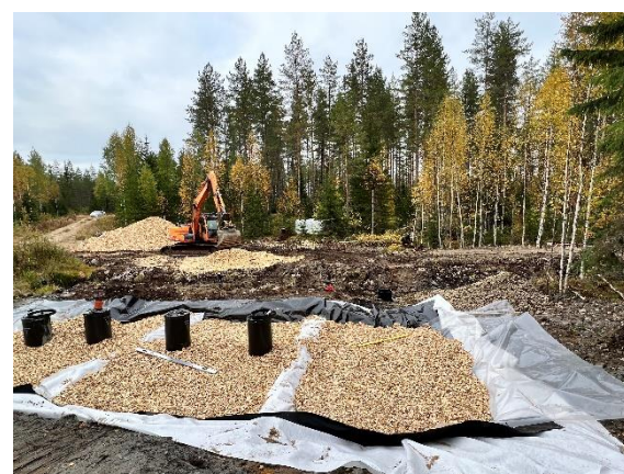
j. Väliseinät ohjaavat virtaamat tasaisesti koko rakenteeseen
