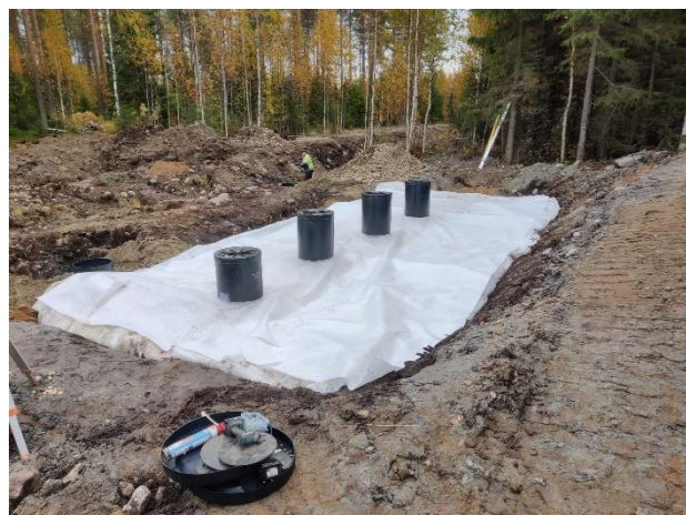
r. Huputettu ts. vain Suursuon laskuojasta vedet pääsevät reaktoriin
