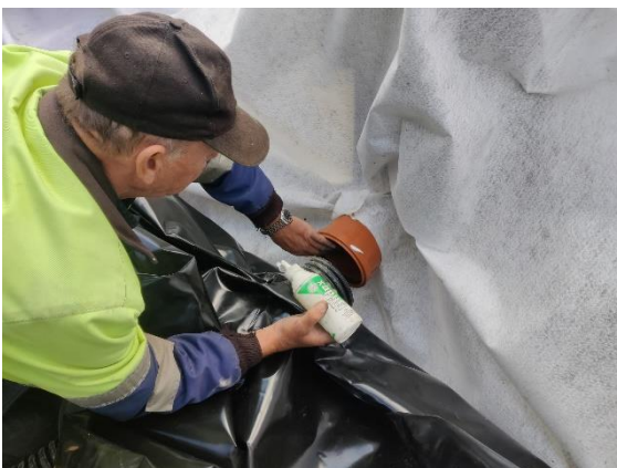
x. Tuloputkien tiivistämistä
