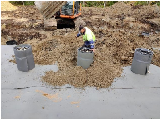
s. Routamatto bioreaktorin eristeeksi
