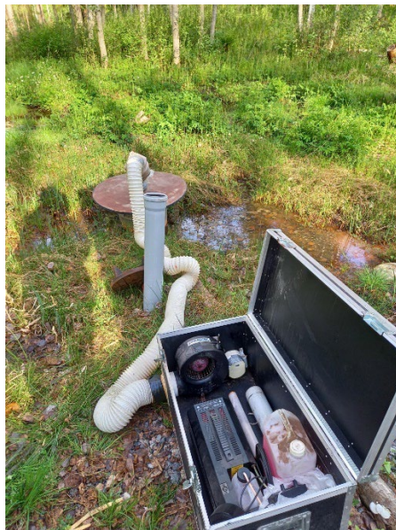
Kuva 2. Savukoelaitteisto asennettuna viettoviemäriin tarkastuskaivon.
