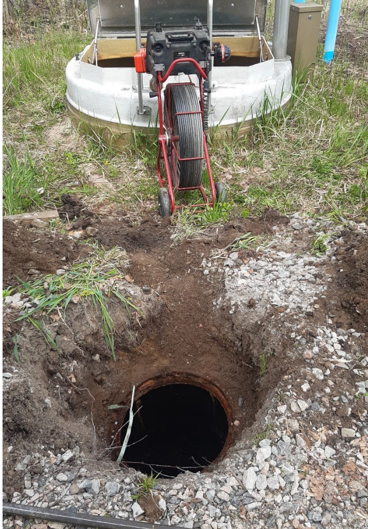
Kuva 5. Koivistonniemen JVP:ltä kartoituksessa löydetty etukaivo.
