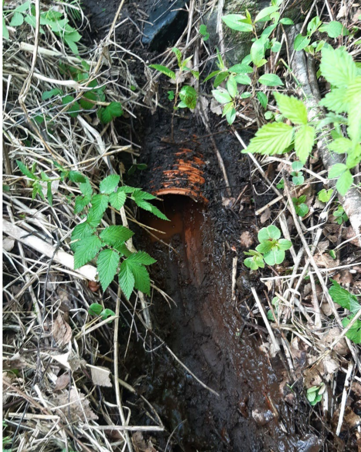
Kuva 4. Löytökylän JVP:n ylivuotoputken pää löydettiin kartoituksessa rantapenkasta.
