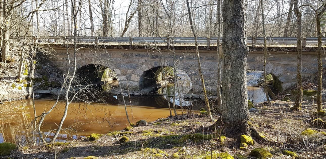
Kuva 2.7. Mälläisten yksityistien 3-aukkoinen kaarisilta Hanhijoen alaosassa.
