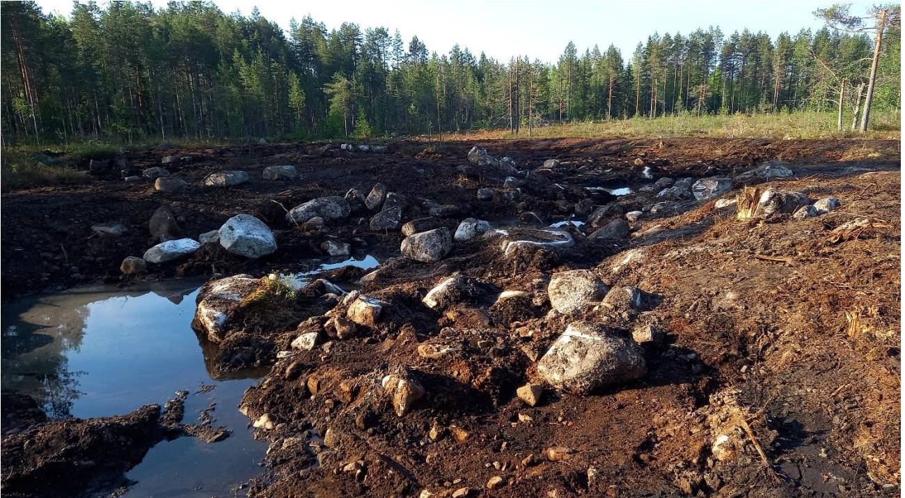
Kuva 8. Kaivussyvänteen suunniteltua sijaintia (valokuvassa etualalla) siirrettiin etelämmäksi maaperän poikkeuksellisen kivisyyden seurauksena.
