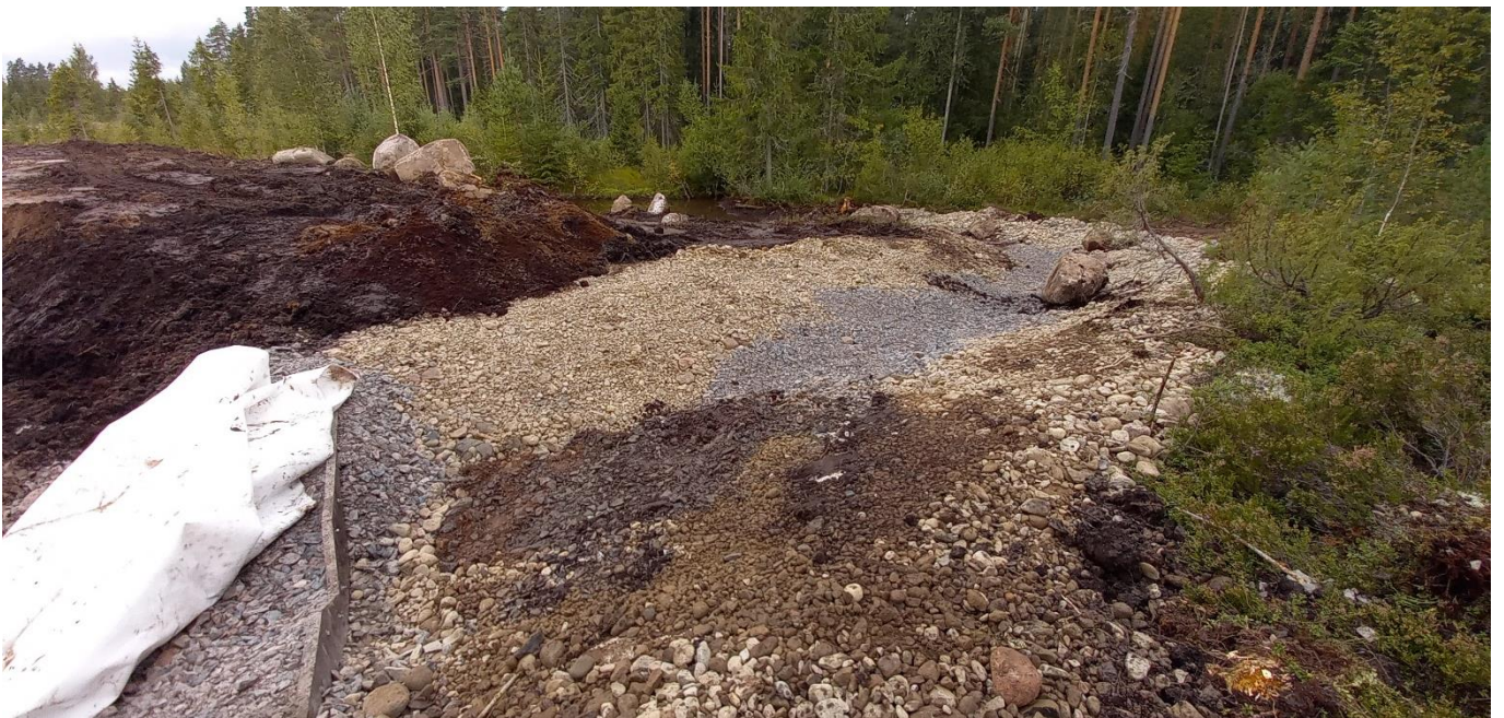
Kuva 13. Pohjapadon ja sen alapuolisen virtausuoman rakentamisessa käytettiin erikokoista
