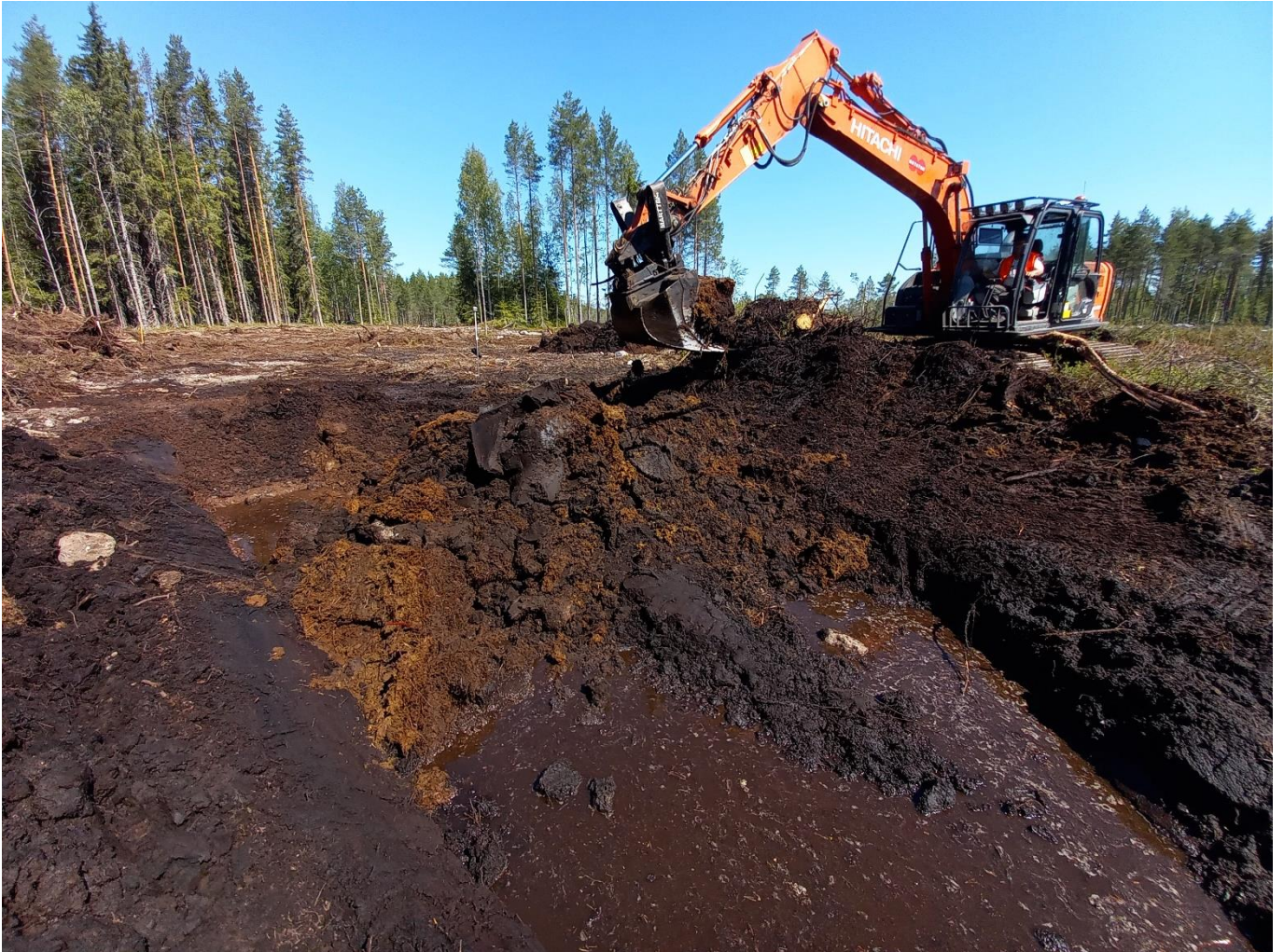
Kuva 9. Patopenkereen vedenpidätyskyvyn aikaansaamiseksi käytetty patorakennustekniikka. Pohjamaan pinnasta noin 50 cm syvyyteen moreenimaahan ulottuva kaivanto täytettiin ja tiivistettiin rahkaturpeella, josta myös padon kosteikon puoleinen luiska kokonaisuutena rakennettiin.
