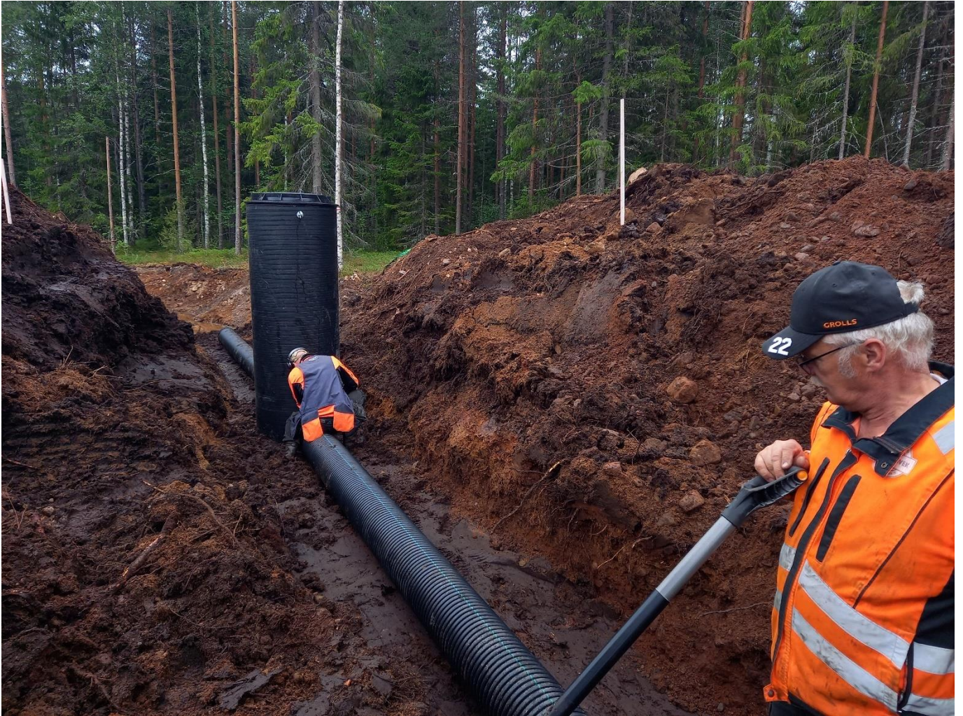
Kuva 11. Kosteikon patokaivon asentamistyötä 05.07.2024. Putkiliitosten kiinnipysyminen varmistettiin haponkestävillä ruuveilla.
