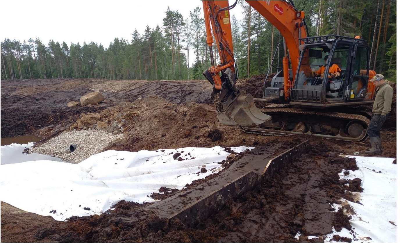
Kuva 12. Mittapadon asentamista KULMALAN tilan kosteikkokohteella 08.07.2024. Patolevy (1,25 m x 5 m) asennettiin ympäriinsä rahkaturpeella tiivistettyyn kaivantoon.
