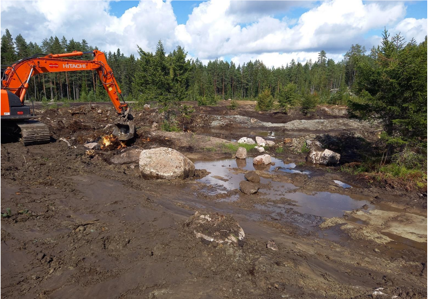
Kuva 15. Koveskoskisen tilan kosteikon rakentamistöiden viimeistelyä 19.08.2024. Kosteikkoalueelle puunpoiston yhteydessä jätetyt latvotut kuusiryhmät sekä rakentamisaikana toteutetut saarekkeet, niemekkeet ja kiveämiset lisäävät merkittävästi kosteikkoympäristön elinympäristöarvoa sekä maisemallista moni-ilmeisyyttä.
