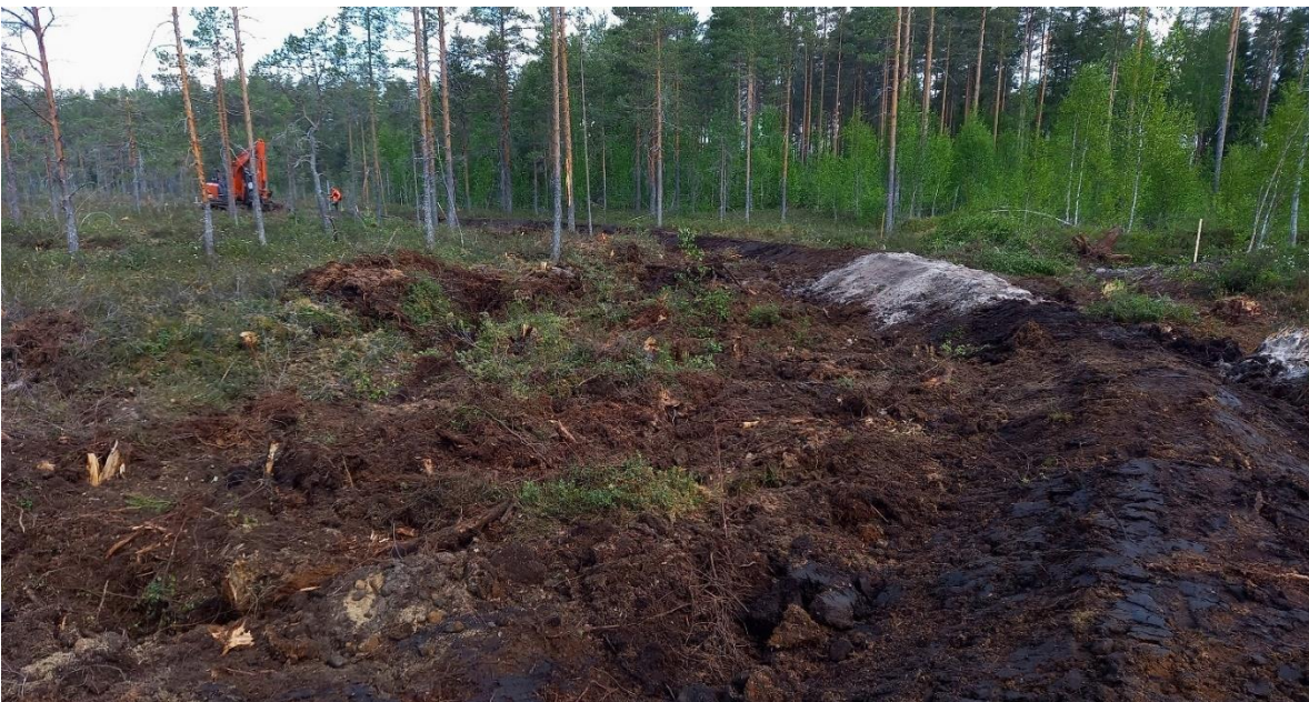
Kuva 7. Paimenkivennevan pohjoispään laskuojan notkoon rakennettiin yhtenäinen patopenger, jonka tarkoituksena oli suon vesien virtaussuunnan kääntäminen etelää kohti.
