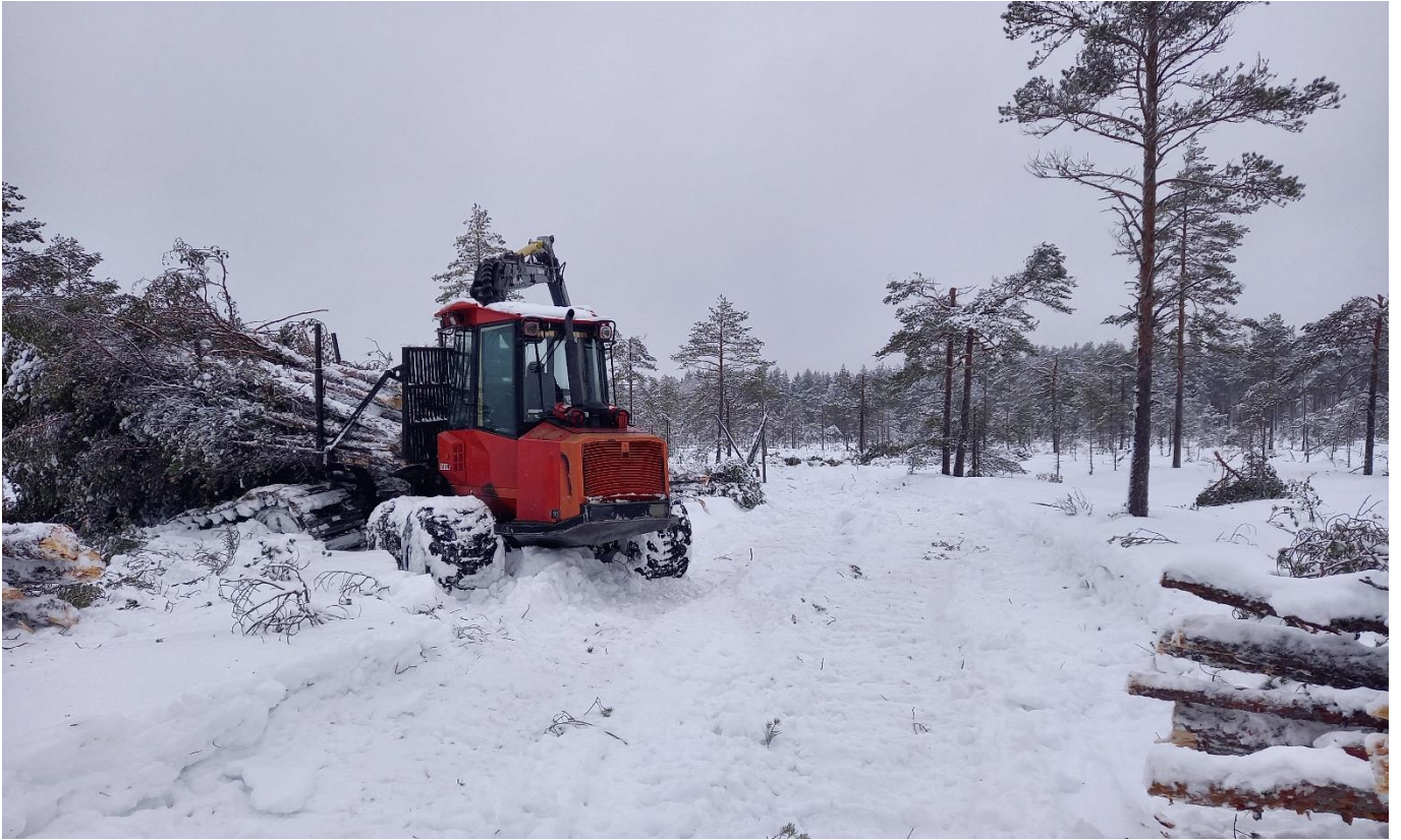
Kuva 4. Puunkorjuutyö suon keskiosista toteutettiin ajokoneella, jossa vain kuormatilan puoleiset pyöräparit oli varustettu pintapainetta alentavilla ja koneen etenemiskykyä parantavilla teloilla. Suon pehmeimmissä keskiosissa ajokoneen eteneminen keskeytyi toisinaan koneen painumisen seurauksena (kuvassa), jolloin ajokuormaa oli kevennettävä puunajon onnistumiseksi.
