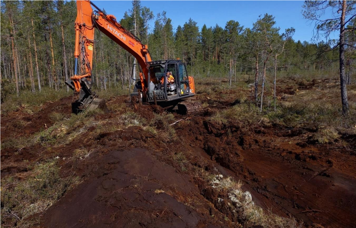
Kuva 6. Suo-ojien perustäytön lisäksi ojiin rakennettiin veden levittäytymistä edistäviä maapato- ja pintavallirakenteita.
