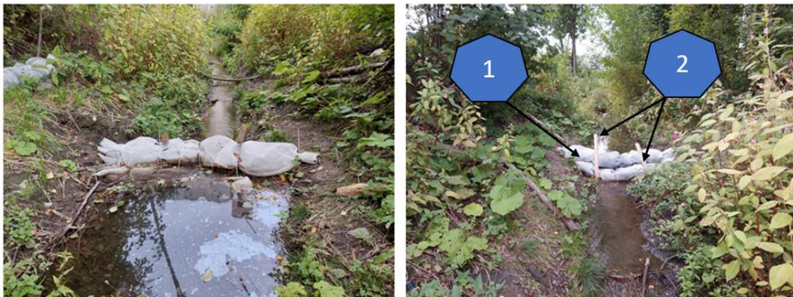
Kuva 1. Biohiilipato: biohiilisäkit (1), tukipaalut (2).
