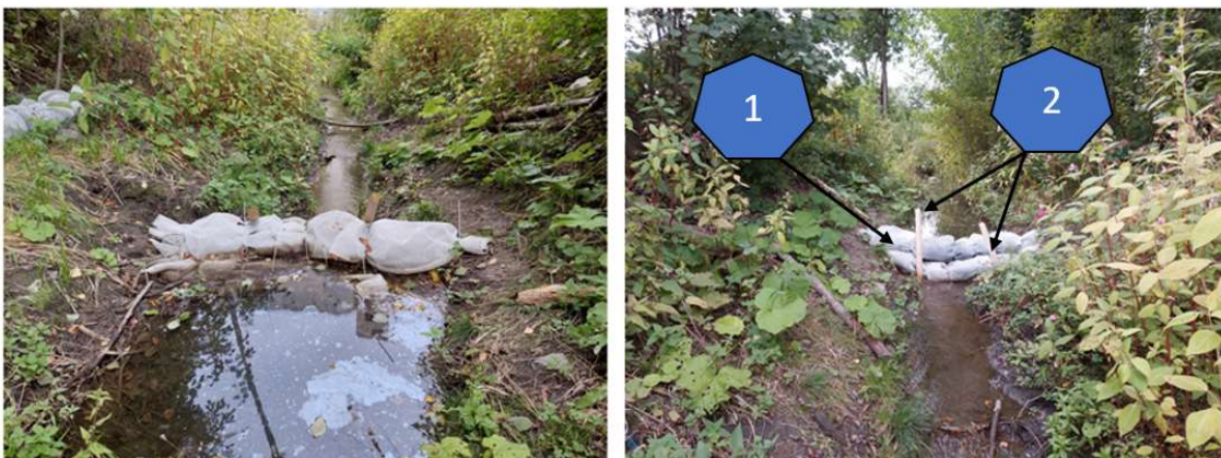
Kuva 15. Biohiilipato: biohiilisäkit (1), tukipaalut (2).
