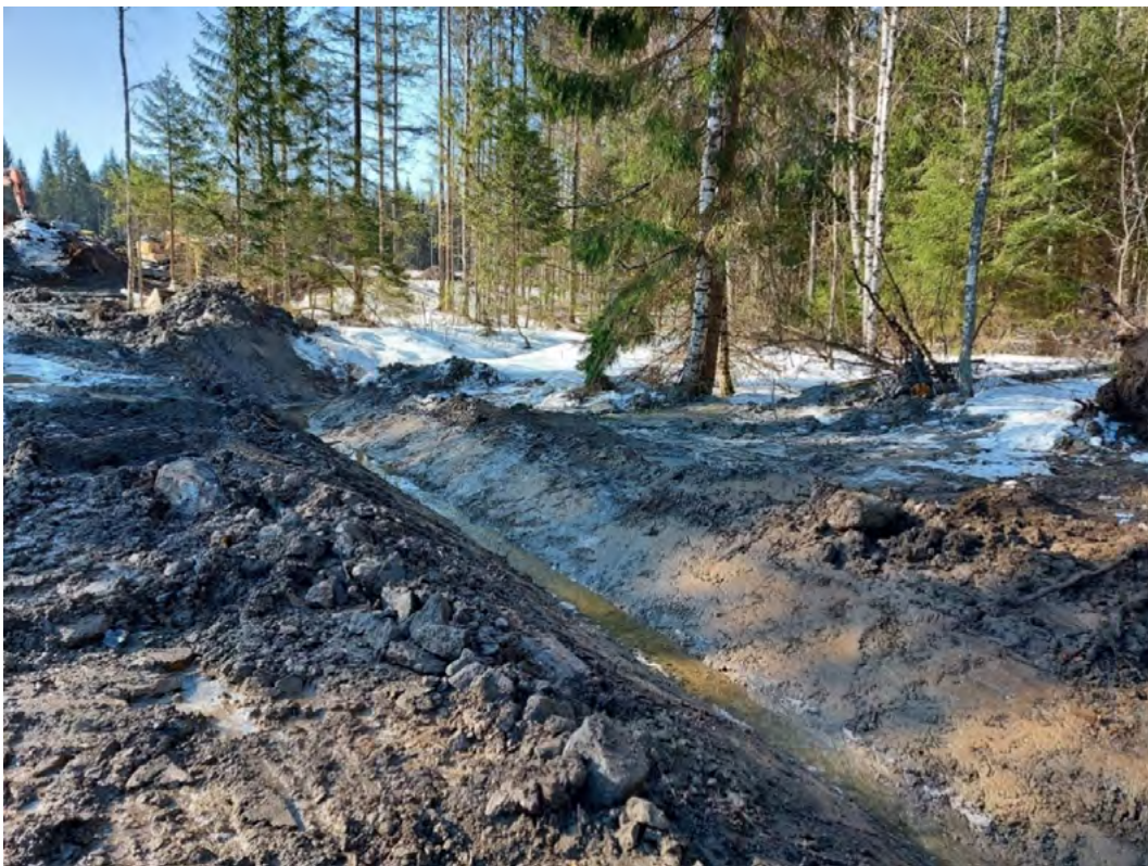
Kuva 1. Tyypillistä aluerakentamisen työmaa-aluetta, jossa sulamisvedet pääsevät esteettä huuhtelemaan mukaansa maa-ainesta paljaalta ja löyhtyneeltä maanpinnalta. Valokuva Ramboll / Päivi Paavilainen 2021.
