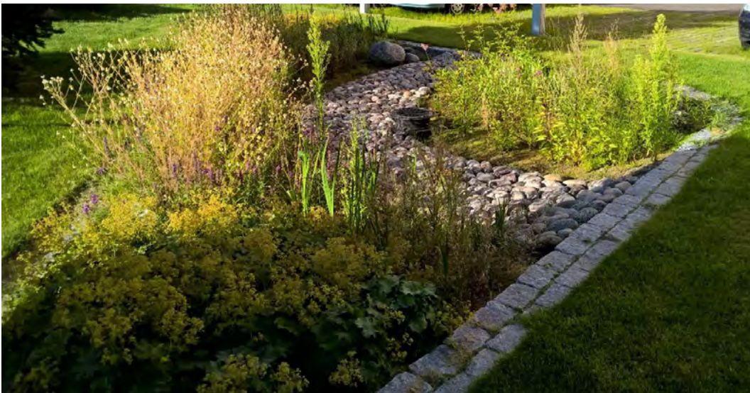
Kuva 13. Biosuodattimen huolto on huomioitu rakentamalla suodattimen pohjalle kiveys- alue, josta kiintoainesta on helpompi poistaa kuin kasvillisuuden keskeltä. Valokuva Ramboll / Päivi Paavilainen 2015.
