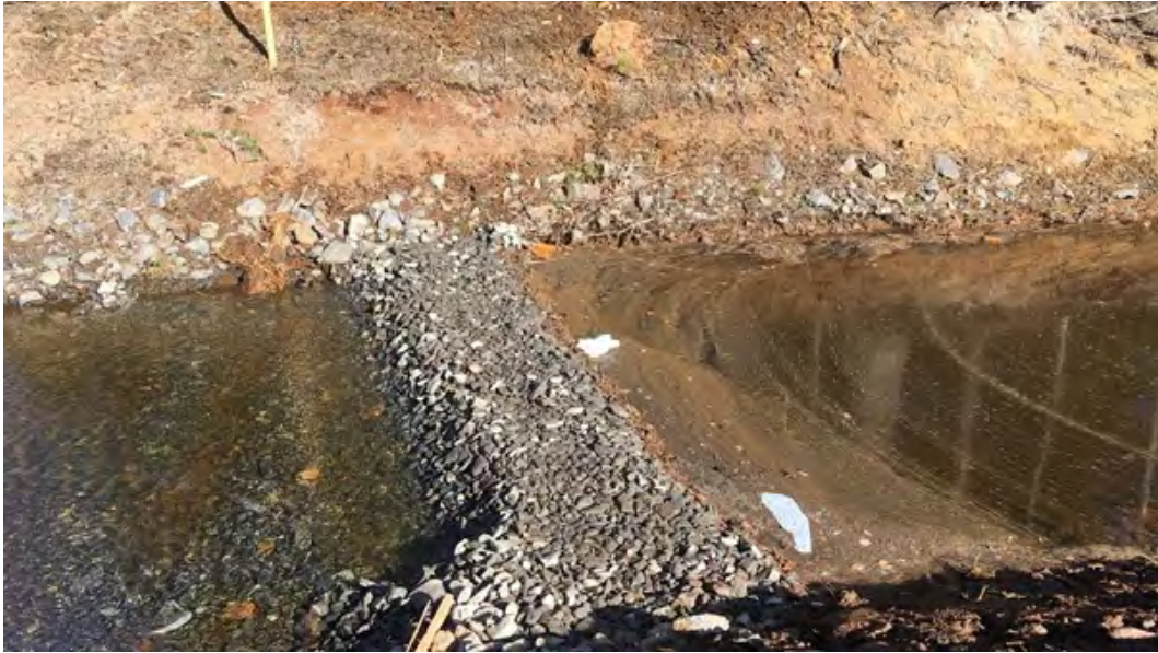
Kuva 18. Karkeasta aineksesta toteutettu suotopato hulevesien esikäsittelyssä (kelluvan roskan ja karkean kiintoaineksen poisto) ketjutetussa järjestelmässä. Patoon on yhdistetty pieni laskeutustila yläpuolisessa ojastossa. Valokuva Mikkeli, Hulevesien käsittelyn T&K-ympäristö-investointihanke.
