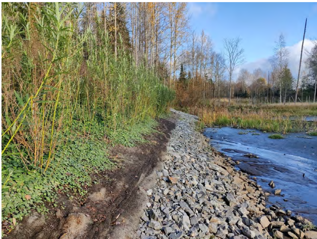
Kuva 17. Kasvipeitteinen suotopato hulevesien käsittelyssä. Kuva padon purkupuolelta. Valokuva Ramboll / Marko Ahola 2020.
