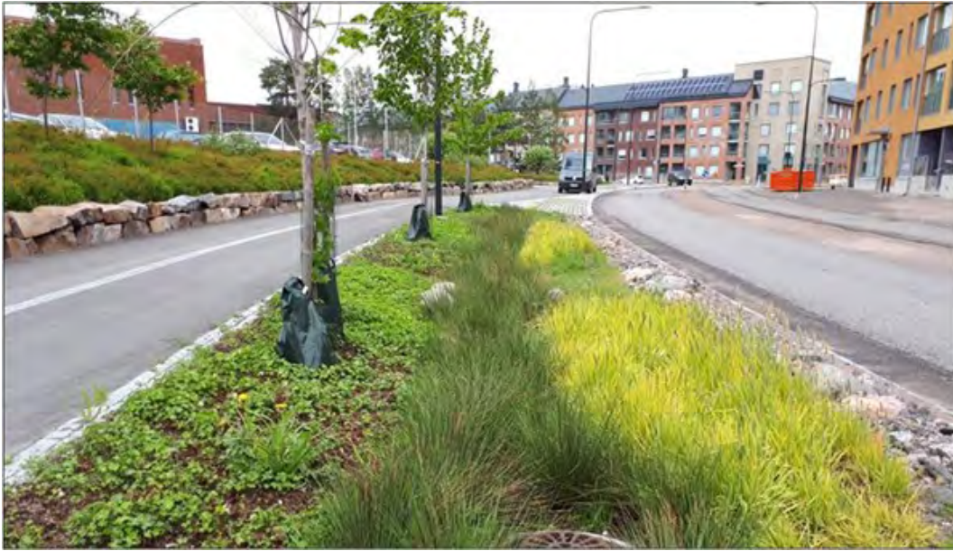
Kuva 12. Katutilaan integroitu hulevesien käsittely biosuodattimella. Valokuva Ramboll/Heta-Maija Seppälä 2022.
