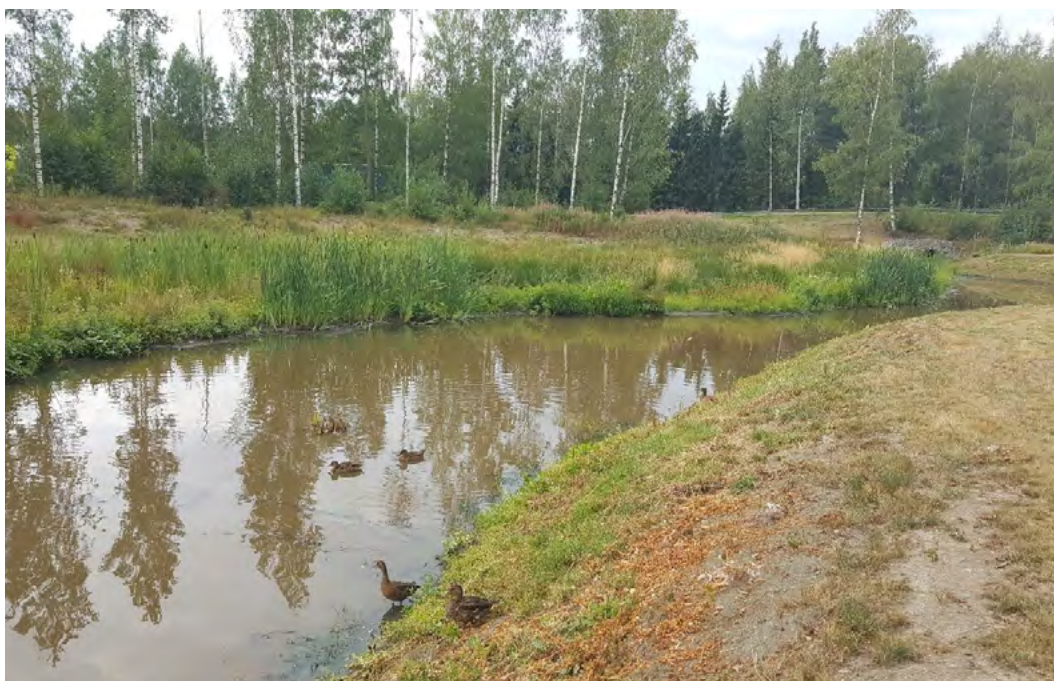
Kuva 20. Luonnonmukainen uoman levennyksenä toteutettu laskeutusallas, jota ympäröivä tulvaniitty tasoittaa virtaamia ja parantaa altaan toimintaa tulvatilanteissa. Valokuva Ramboll / Johanna Jalonen 2018.
