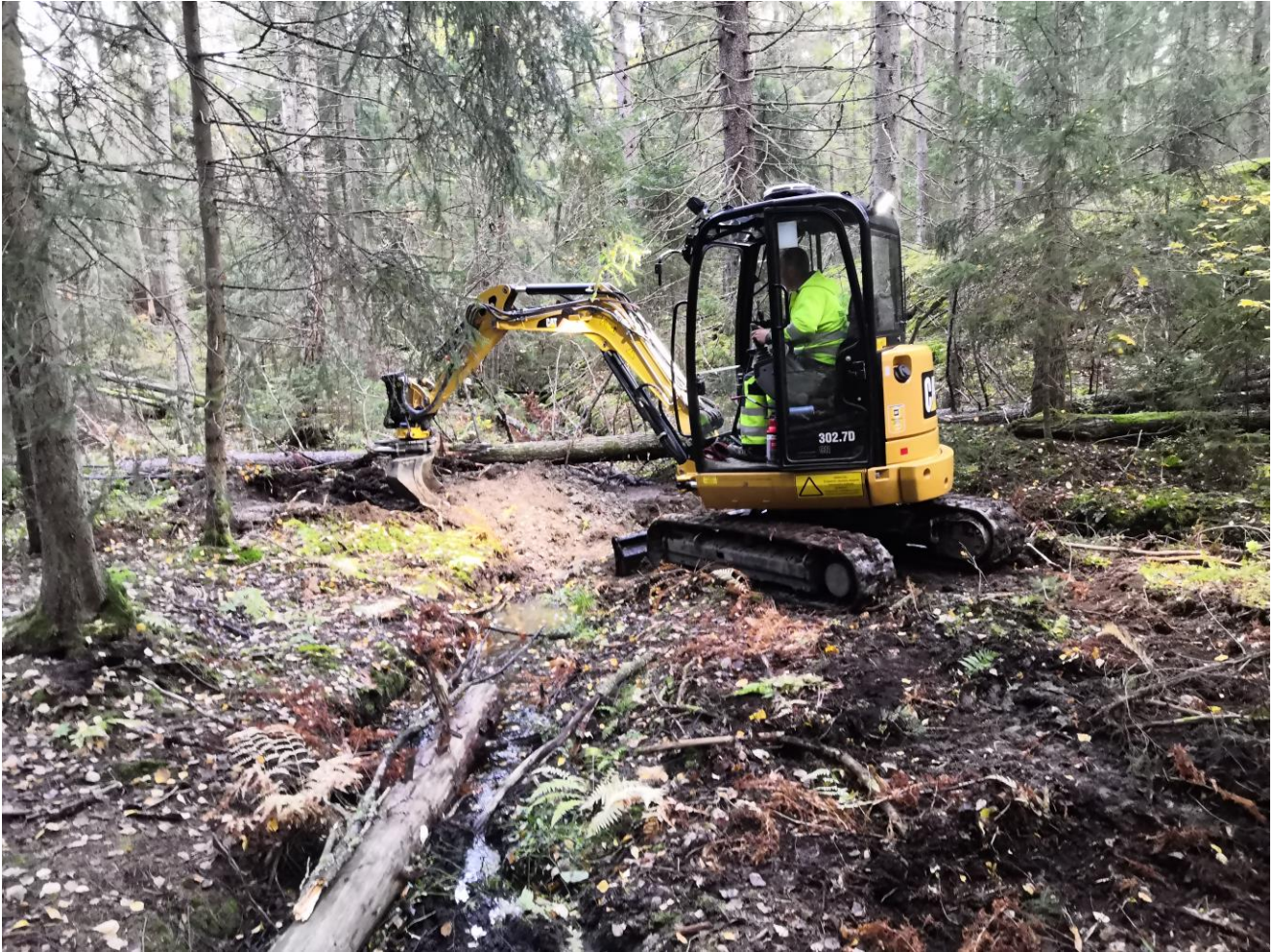
Kuva 10. Kuivuneen korven läpi kulkevan ojan alaosaan rakennettiin pato vesien pidättämiseksi turvamaa-alueelle.
