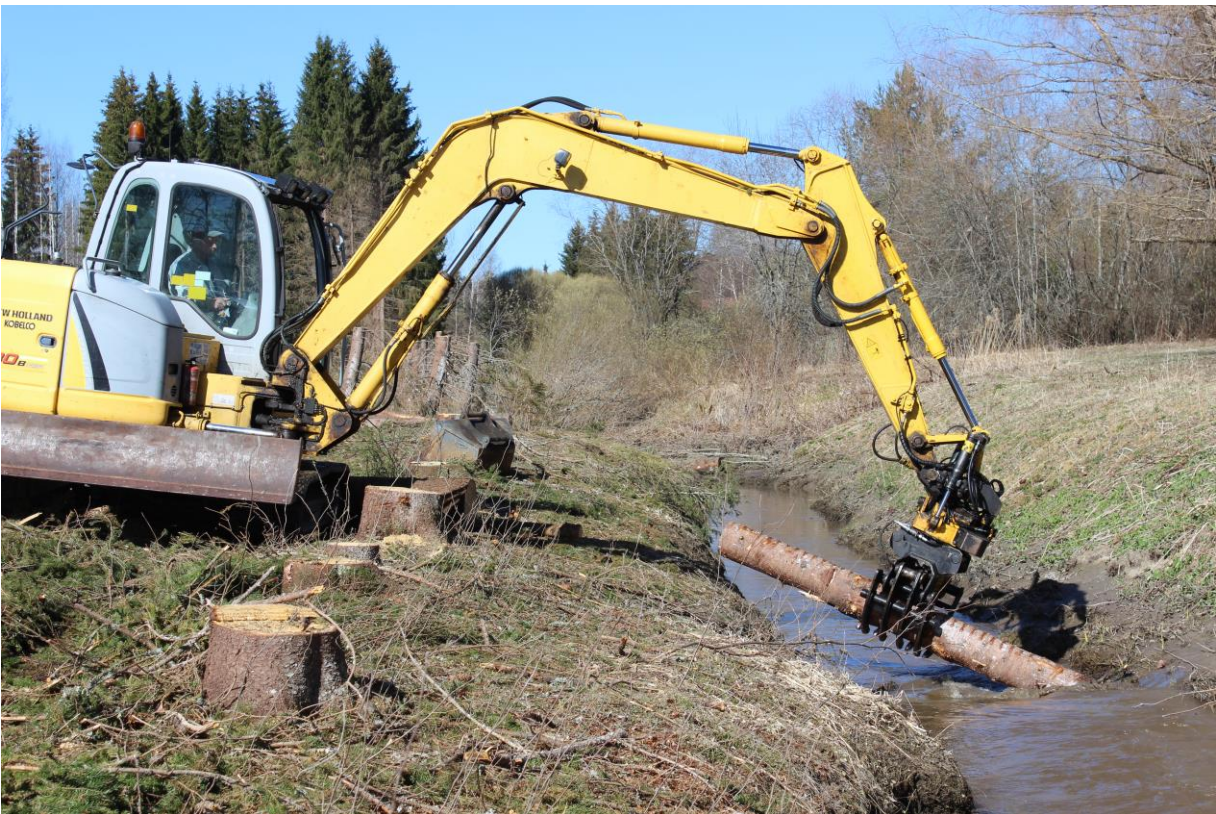
Kuva 14. Karhunojaan lisättiin suurikokoista puuta monimuotoistamaan uoma.
