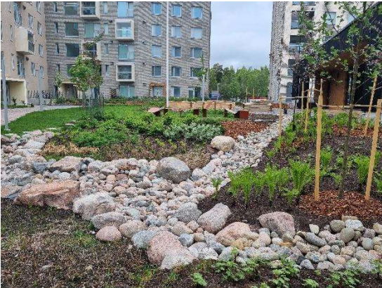
Kuva 19. Kerrostalopiha Helsingin Pasilassa, jossa hulevesien imeyttäminen tontille on otettu hyvin huomioon.
