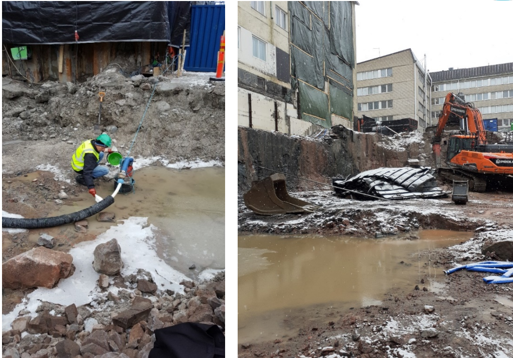
Kuva 3. Vasemmalla näytteenottoa kaivantovedestä Meilahden sairaalatyömaalla, oikealla purkutyömaa Lauttasaassa
