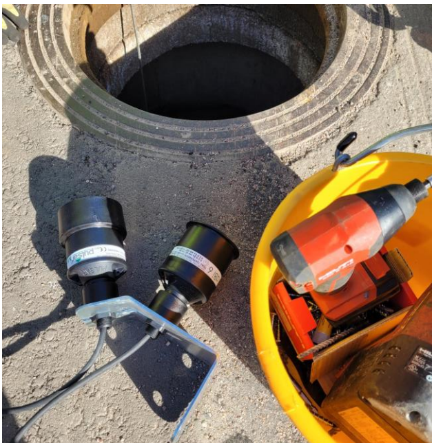
Kuva 8 anturipari (pinnankorkeus ja nopeus) valmiina asennettavaksi kaivoon
