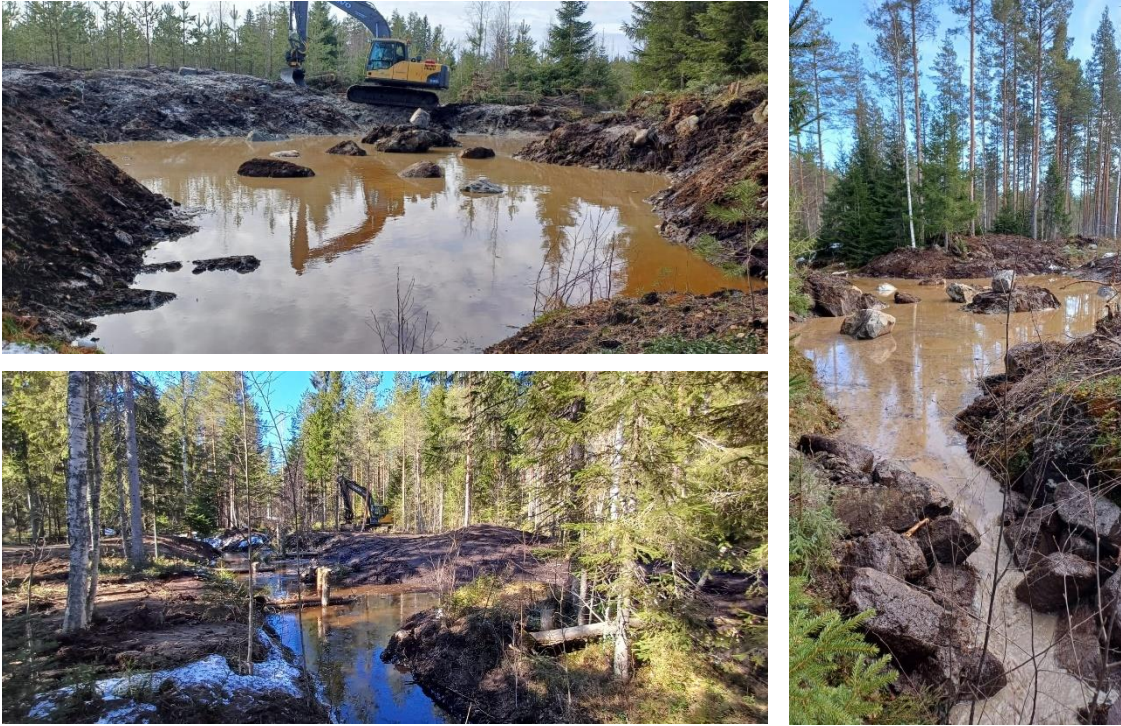
Kuva 5. Viivytyksaltaiden rakentamista keväällä 2025 (kuvat Markus Niskanen).
