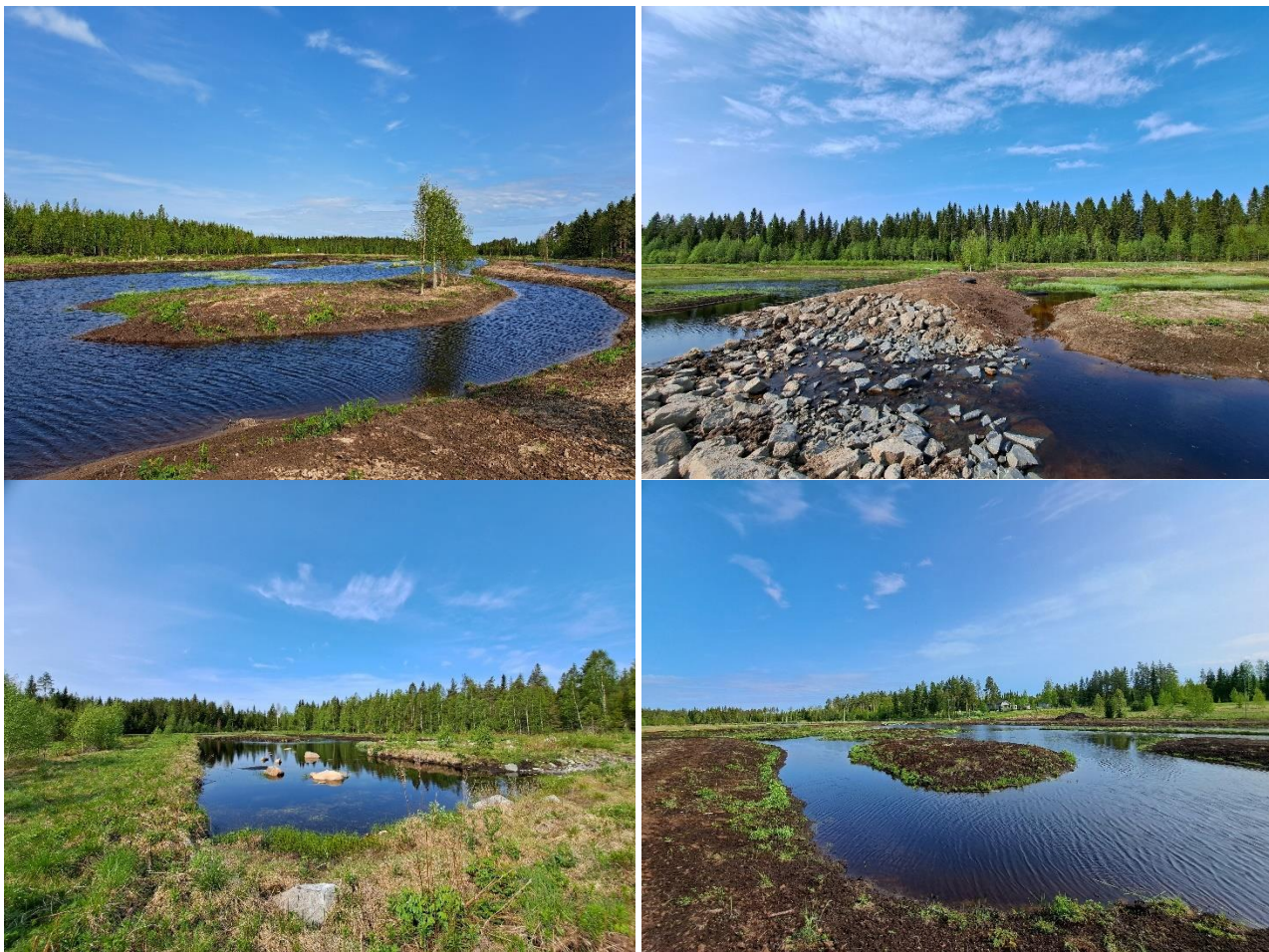
Kuva 13. Latvalan kosteikkoalue valmiina kesäkuussa 2025. Kosteikolle jätettiin saarekkeita, ja siinä on matalan ja syvemmän veden alueita. Kosteikon eri alueet on erotettu toisistaan penkereillä, joihin rakennettujen pohjakynnysten kautta vesi virtaa alueelta toiselle (kuvat Elina Kajava).
