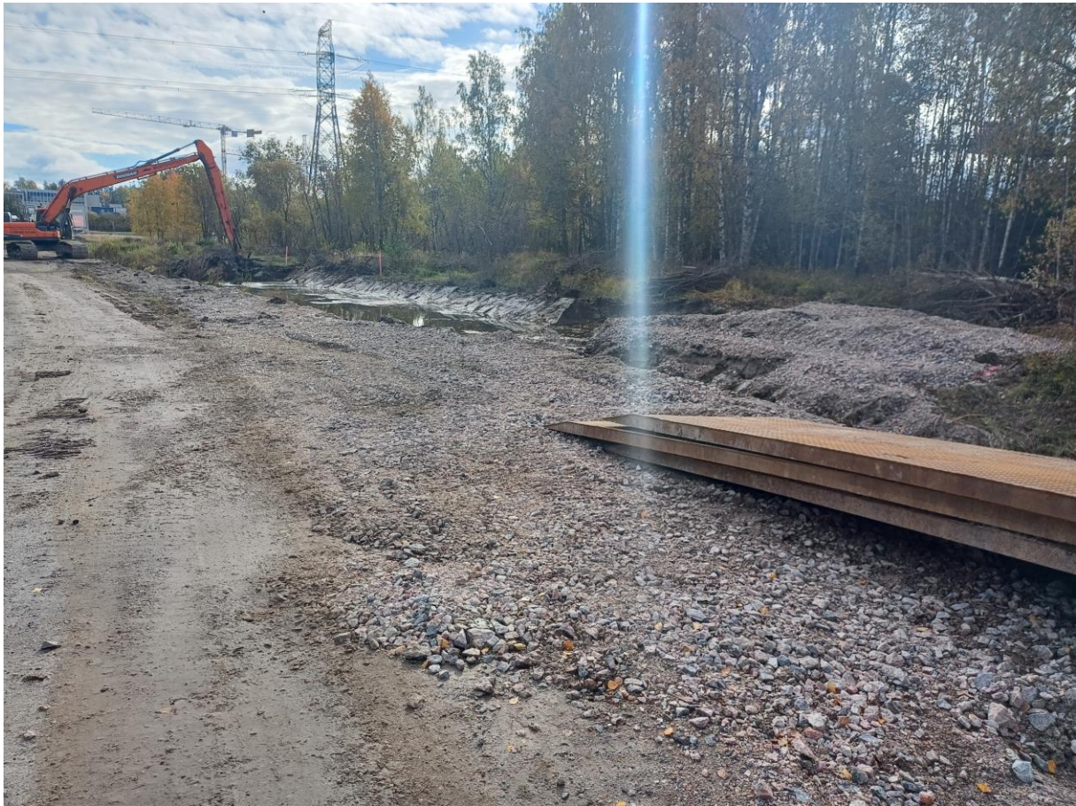
Kuva 11. Varistonojan tulvatasanteen toteutus, kuvattu 7.10.2024 (Iiro Lehtinen, Vantaan Kaupunki)
