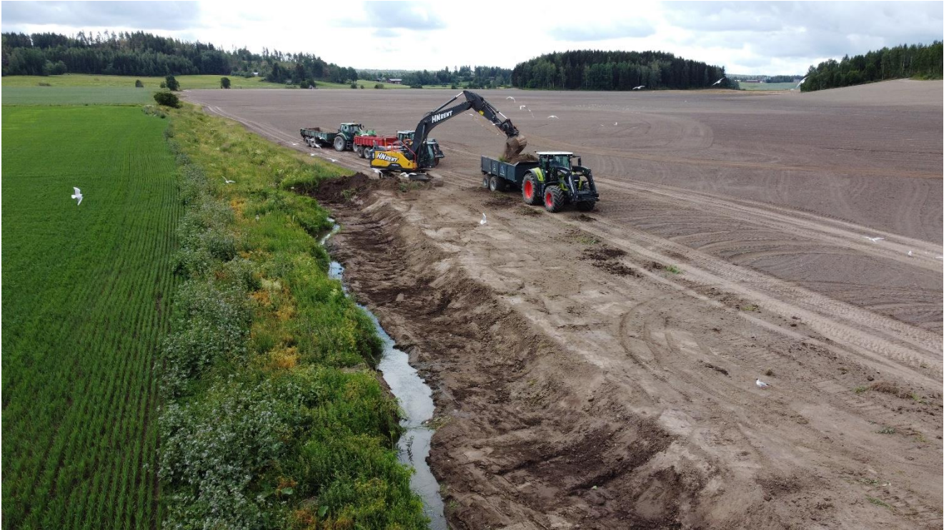
Kuva 18 Norrbybäckenin kaksitasouomaa rakennettiin heinäkuussa 2023. Copyright: Viivi Kaasonen / WWF Suomi
