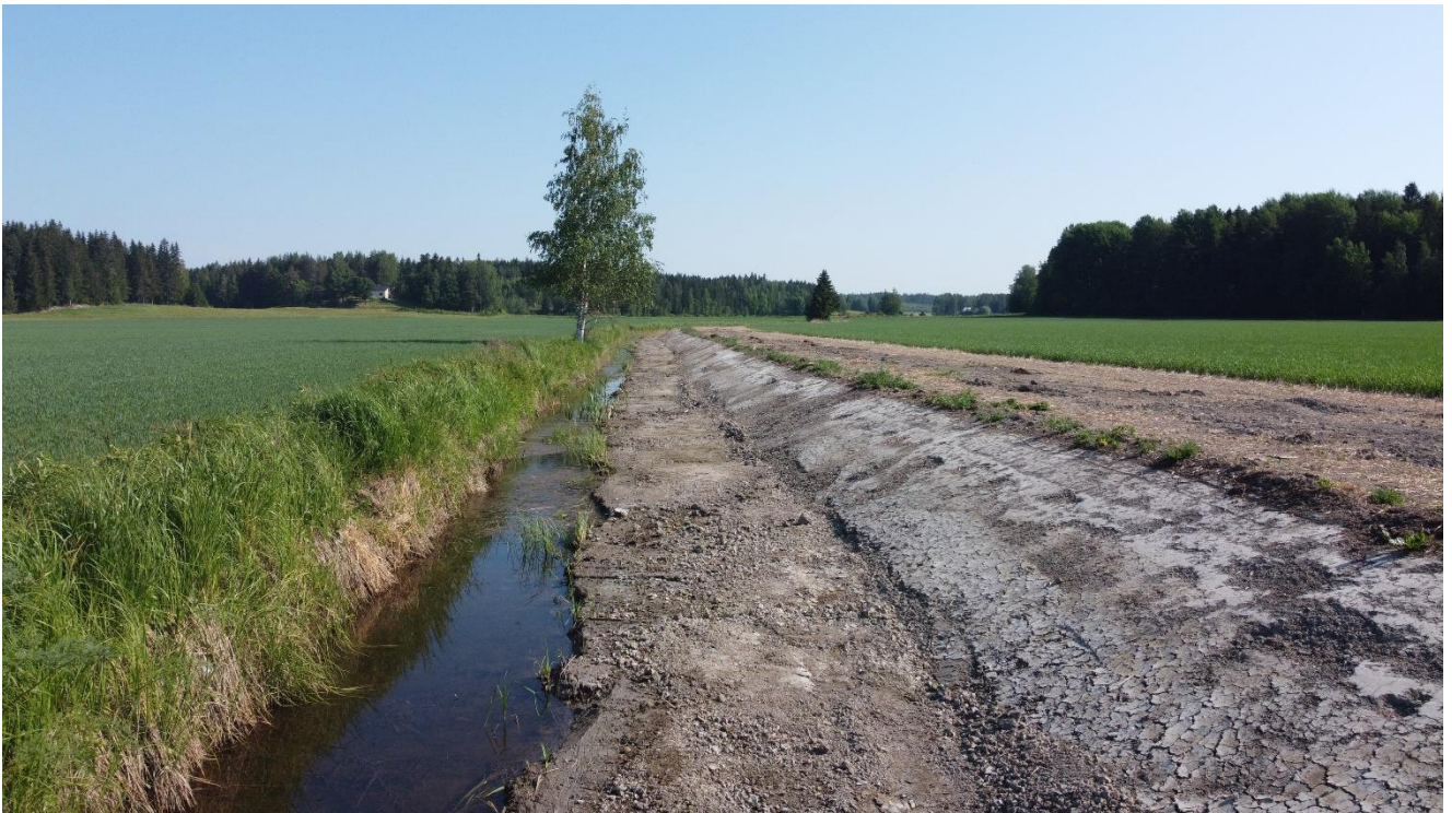
Kuva 2 Långbroån kaksitasouoma pian rakentamisen jälkeen kesäkuussa 2023. Copyright: Viivi Kaasonen / WWF Suomi
