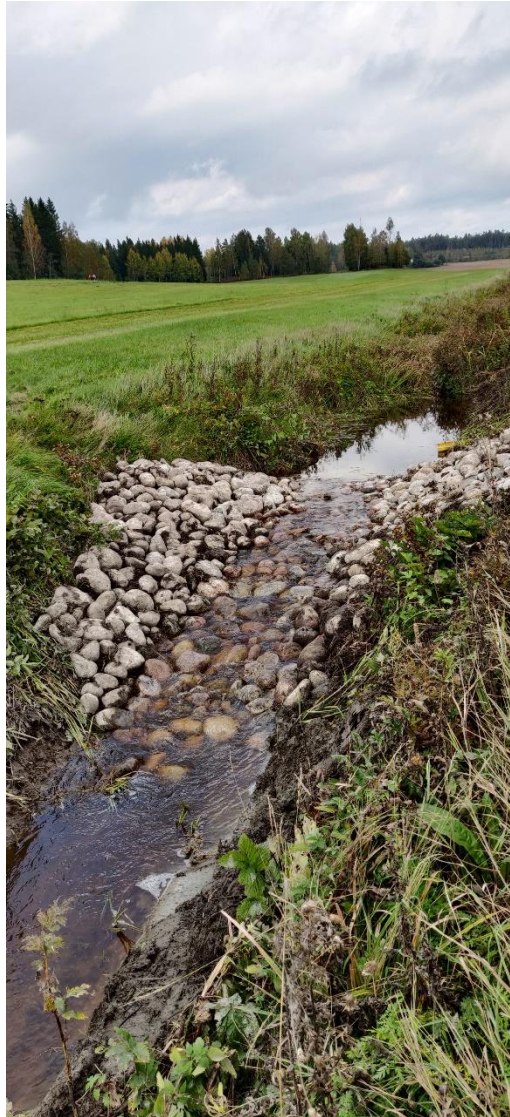
Kuva 3 Valmis pohjakynnyks Långbroån uomassa lokakuussa 2023. Copyright: Viivi Kaasonen / WWF Suomi
