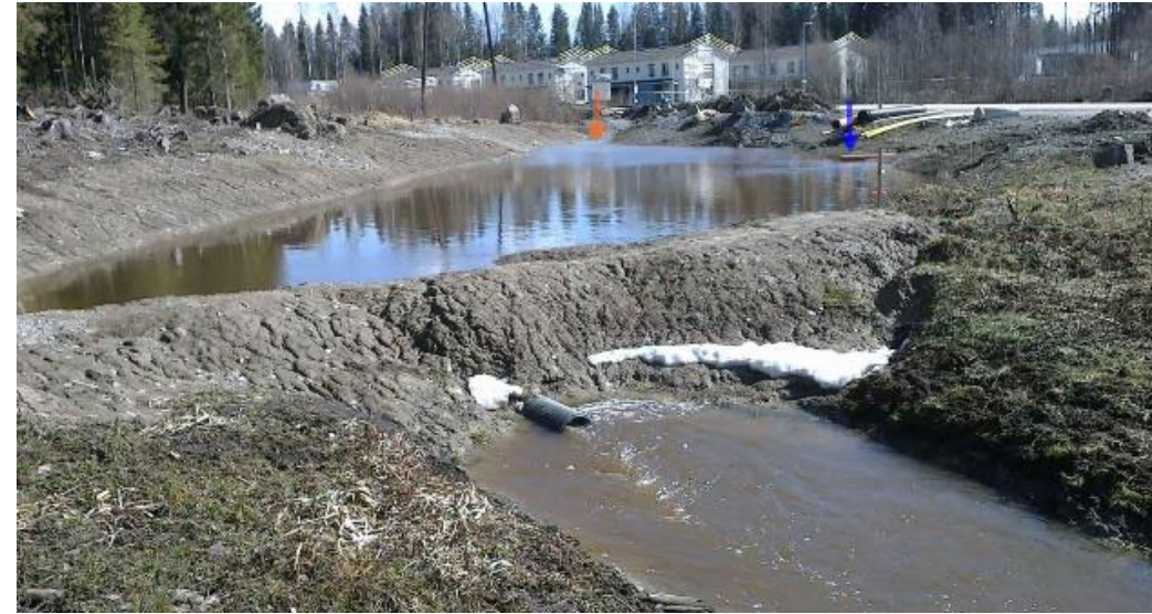
Kuva: Heikosti toimiva laskeutusallas. Altaan heikko toiminta näkyy silminnähden myös alapuolisen ojan vedenlaadussa
