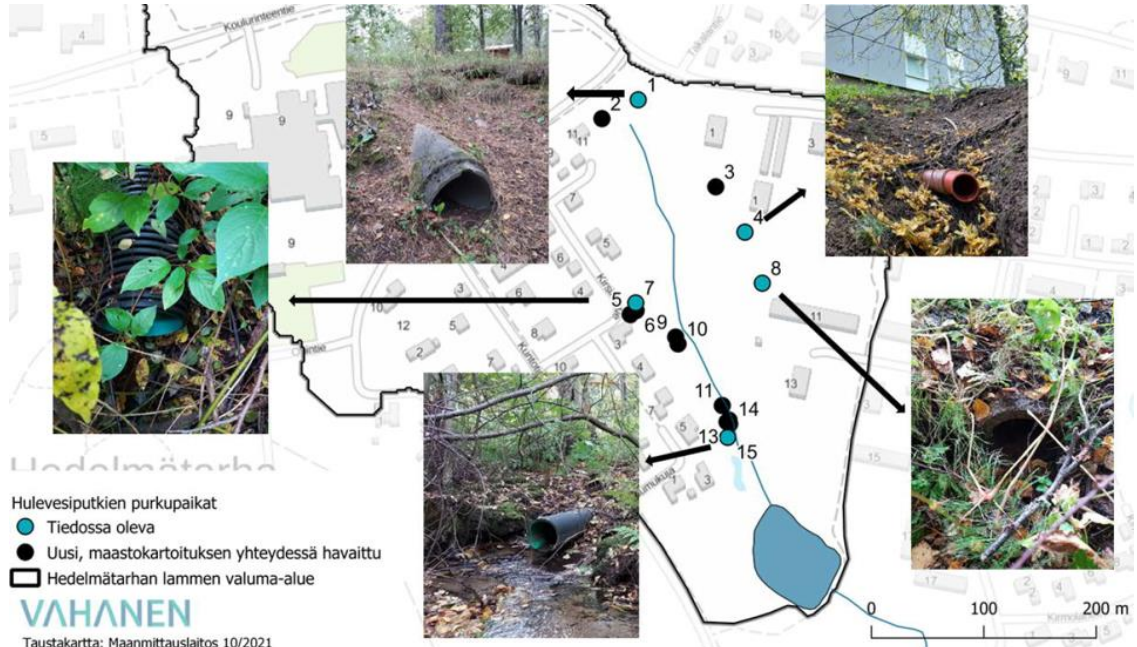
Kuva 3. Alueella ennalta tiedossa olleet hulevesien purkupaikat sekä vuonna 2021 havaitut purkupaikat. Lähde: Vahanen Environment Oy 2021.
