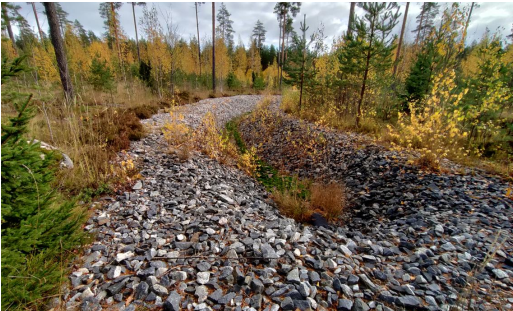
Kuva 10. Tutkimuspiste SW-S1, Tiiriskankaantien hulevesiallas.
