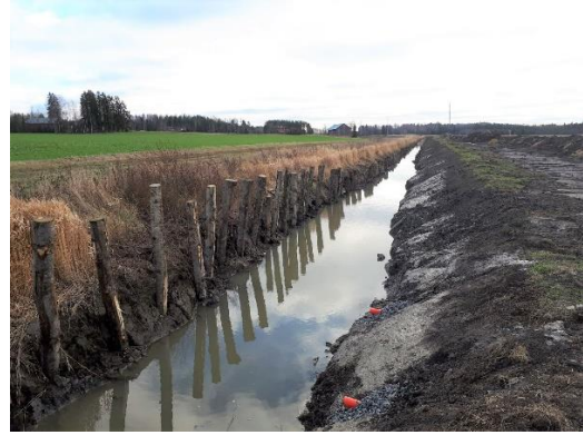
Kuvat 6 -7 Penkan sortuma ja tuenta puupaaluilla. Vasemmassa kuvassa näkyy myös korjattuja salaojaputkia. Kuvat: Janne Heikkinen ja Jaana Hietala.
