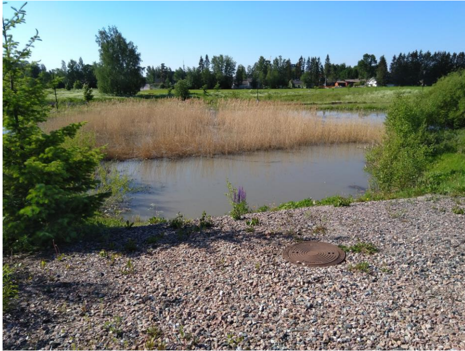
Kuva 1.6. Koisotien lumen vastaanottoalueen biosuodatusallas 11.6.2021. Altaan tuloputki on kuvan alalaidan tarkastuskaivon jälkeen (kuva: VHVSY).
