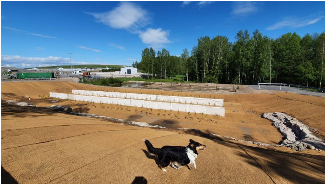
Kuva 24 Suodatusjärjestelmän rakentaminen 2021 kesällä. Biosuodatusalue on jaettu väliseinillä kolmeen osaan, joiden vedet ohjataan eri kaivoihin. Kuva: Ramboll 2021
