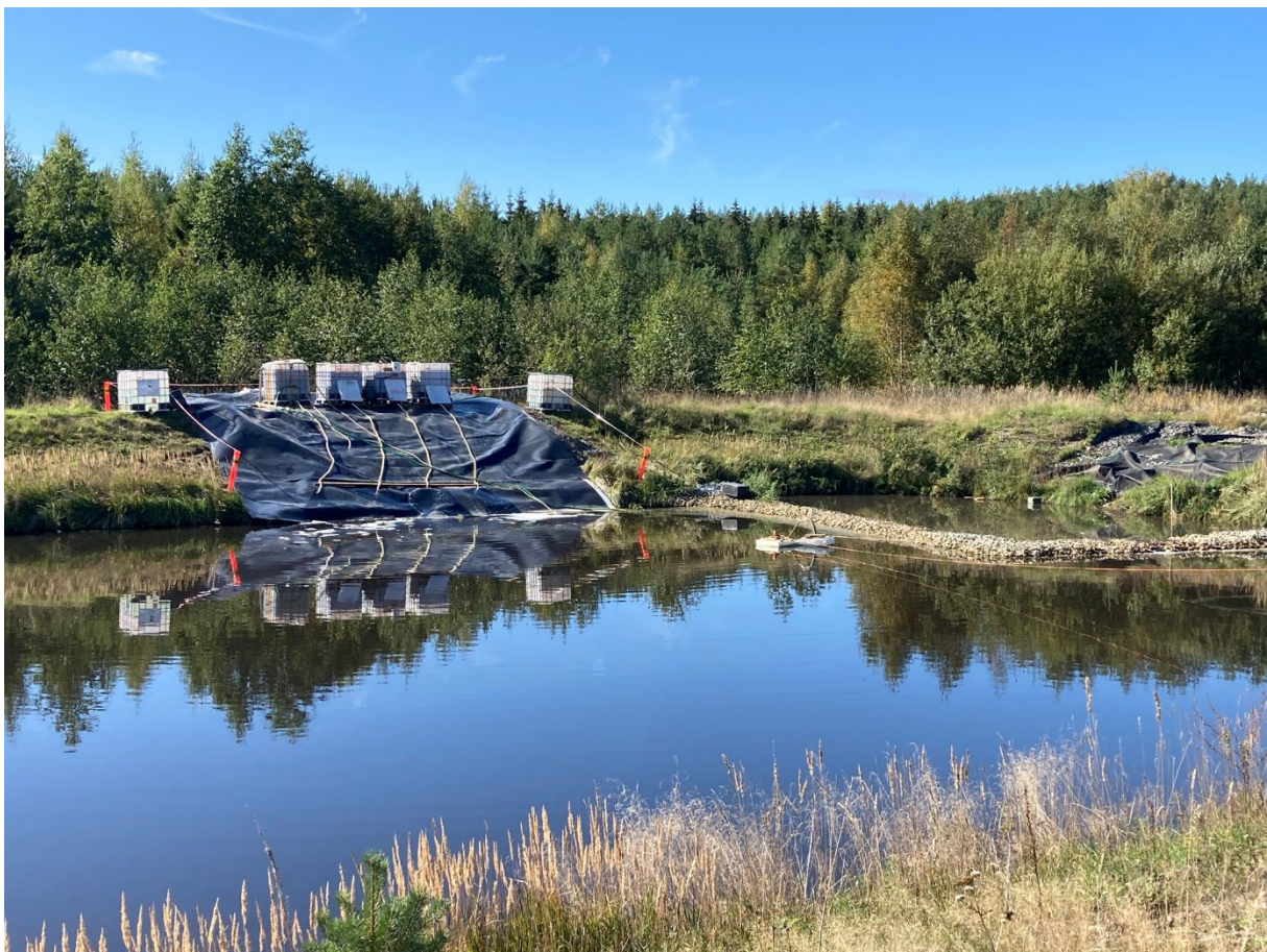
Kuva 21 Tutkimuskohteena ollut Karanojan jätteidenkäsittelyalueen tasausallas. Taustalla vuoden 2021 suodatinkoeasetelma. Kuva: Anu Koponen 2021
