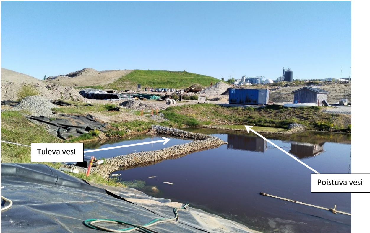
Kuva 1. Karanojan jätteenkäsittelyalueen vuonna 2002 rakennettu tasausallas. Taustalla näkyy jätetäyttöalueita, joilta kerätään vettä tasausaltaaseen. Kuva: Josefiina Ruponen, 2022
