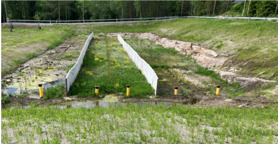
Kuva 26 Kesäkuussa 2022 tehty kasvillisuuskartoitus. Veden huomattiin ohjautuvan kuvassa vasemmalla olevaan alueeseen. Kasvipeite oli vaihtelevaa ja pajut kasvoivat edelleen heikosti. Kuva: Ramboll 2022
