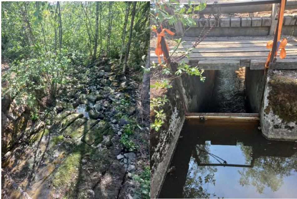
Kuvassa vasemmalla padon alapuolinen koski. Oikealla lankkupato, kuvassa näkyvään kohtaan olisi mahdollista selvittää teknisen kalatien perustamista.
