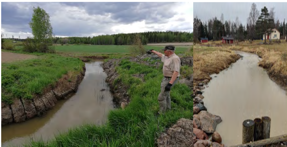
Kuva 3. Piurunjoella pyritään vesienhallintaa parantamaan perinteisten peruskuivatustoimien (vasemmalla) sijaan lisäämällä veden viivytystä pohjakynnysten avulla (oikealla) ja hyödyntämällä luontaisia tulva-alueita.
