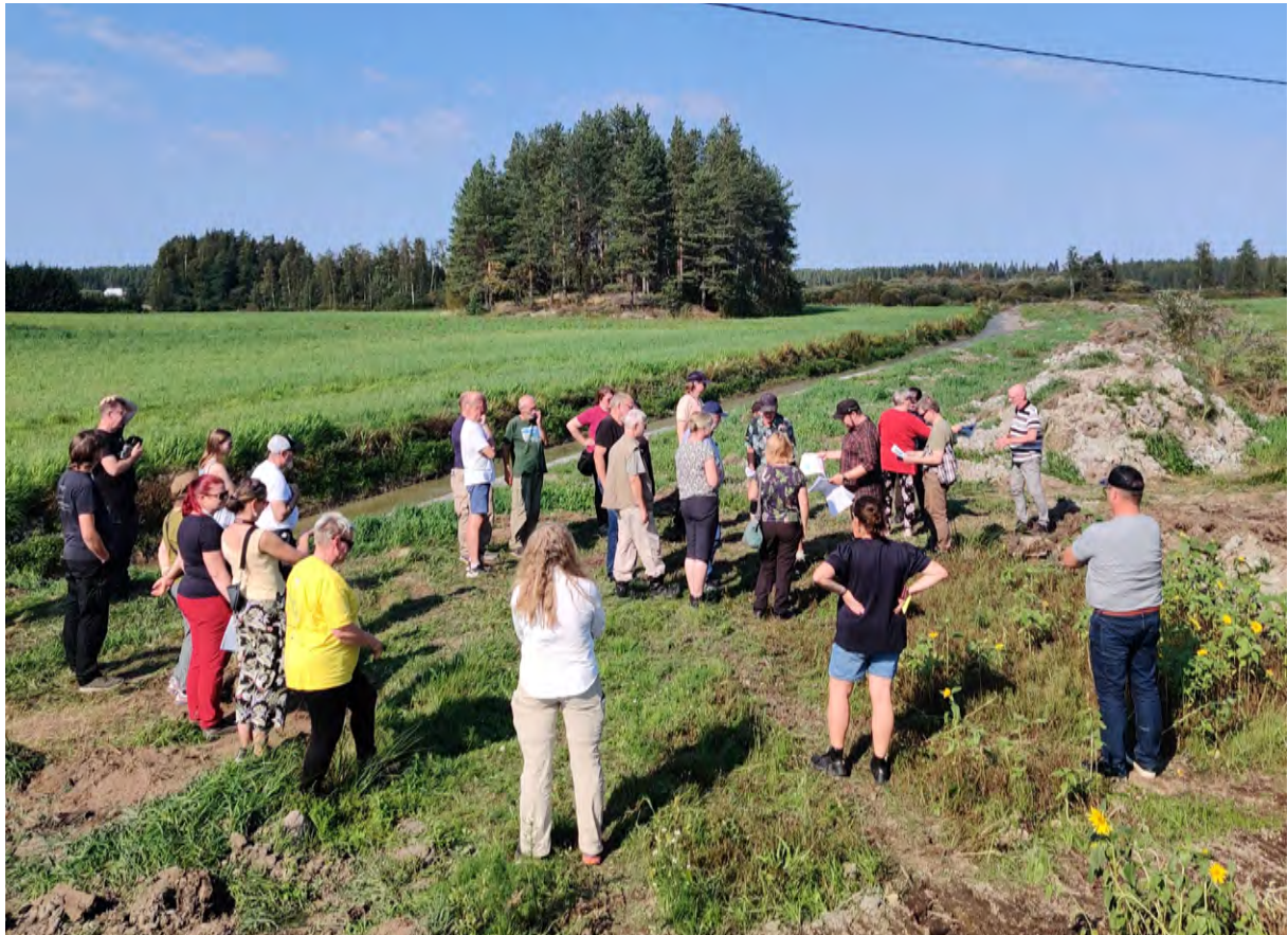
Kuva 7. Kanta- ja Päijät-Hämeen vesistökunnostusverkoston maastoretkellä tutustuttiin mm. 2-tasouomiin ja luonnonmukaisen peruskuivatuksen menetelmiin.
