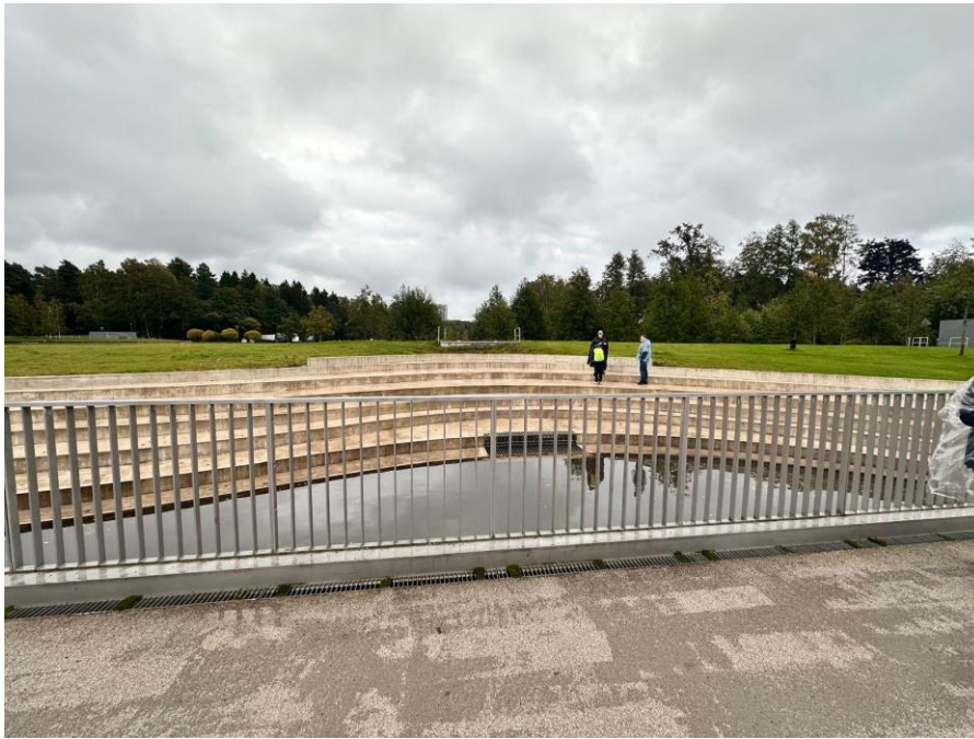
Kuva 6. Espoon Tapiolan tulvasuojelurakenne (Kuopion kaupunki; 2024).
