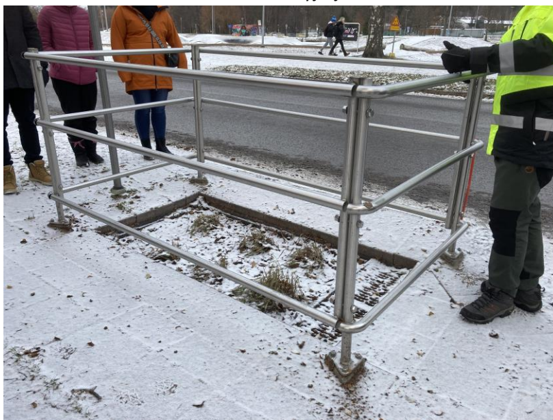
Kuva 3. Rain garden -hulevesielementti Lahdessa (Kuopion kaupunki; 2023).
