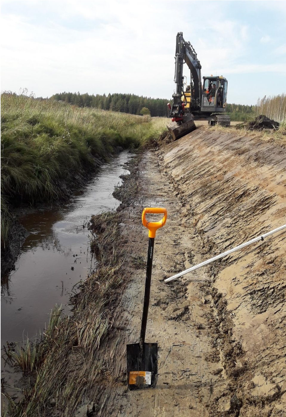
Kuva 5. Naaranojaan rakennettiin noin 350 m matkalle tulvatasanne, joka käsittelee yläpuolisen maatalous ja suometsäalueen valumavesiä. Yläpuolisen valuma-alueen maltillisesta laajuudesta johtuen tulvatasanne toteutettiin verrattain kapeana (noin 1,5 m).
