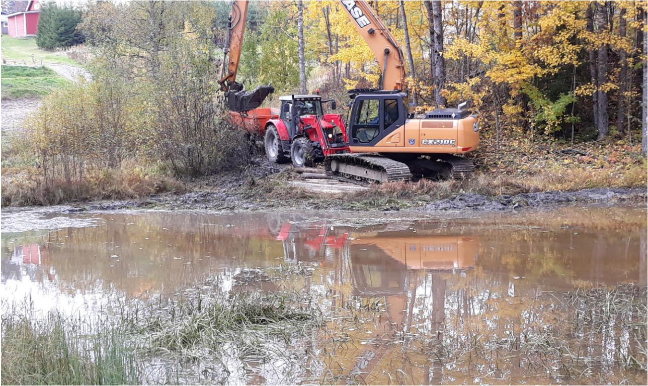
Kuva 7. Imponojan laskeutusallas-kosteikkoyhdistelmän kiintoaineella täyttynyttä yläosaa kunnostettiin syyskuussa 2021.
