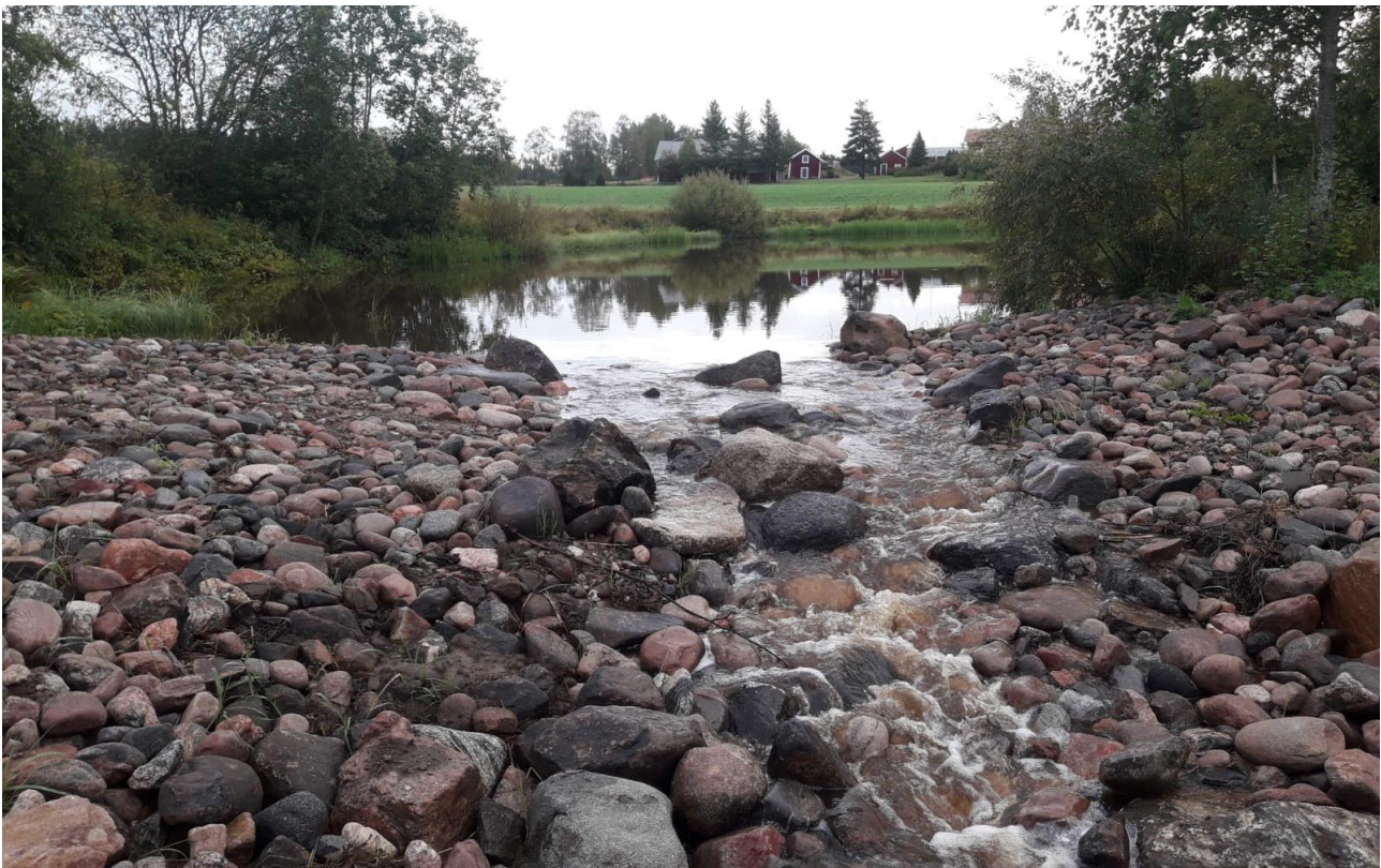
Kuva 6. Kärrilänojan kunnostettu patorakenne syksyllä 2021. Kunnostustyönaikainen kuva raportin kansilehdellä.
