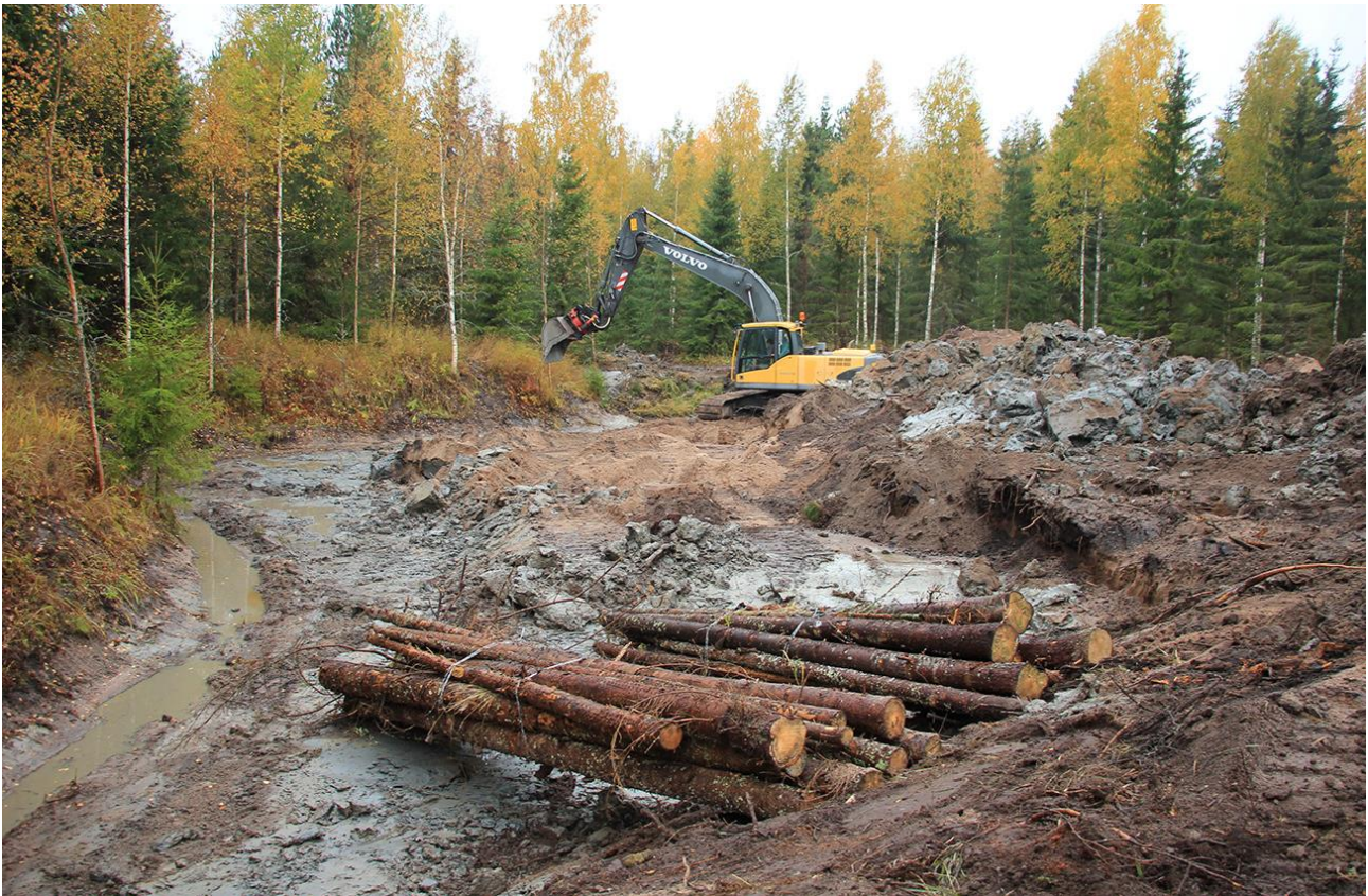
Kuva 3. Toimenpidekohteiden hakkuissa syntynyttä havupuumateriaalia upotettiin altaisiin sekä hyödynnettiin patojen alla vesien käsittelyssä. Ahmasojan ylimmäisen altaan rakennustöitä tehtiin syksyllä 2022.
