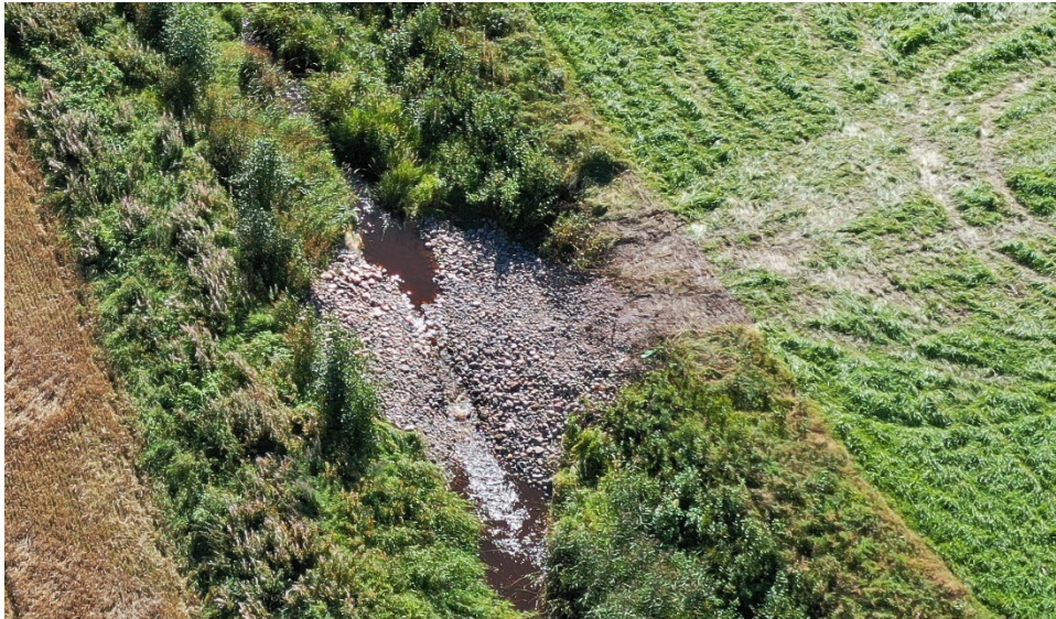
Kuva 5. Dronella otettua ilmakuvaa Leppiojalle rakennetusta pohjakynnyksestä.
