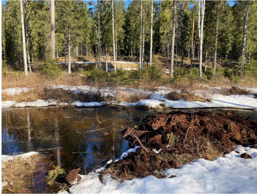
Kuva 3. Turpeesta tehty pato Lopen tutkimusalueella.
