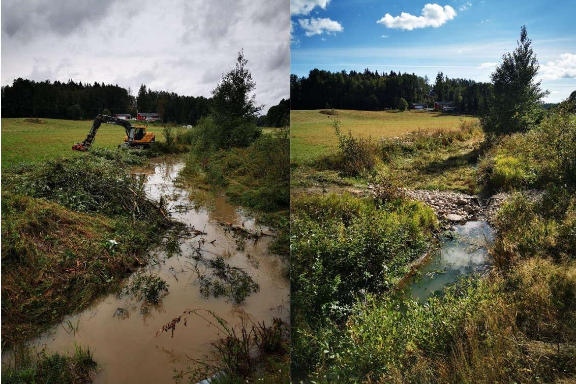
Kuva 4. Kasvillisuuden niitto 2021 tehtiin niittokauhalla tulvatilanteessa, kun taas 2022 olosuhteet olivat erittäin kuivat ja menetelmä erilainen. Pohjakynnys rakennettiin uoman alaosaan kesällä 2022.
