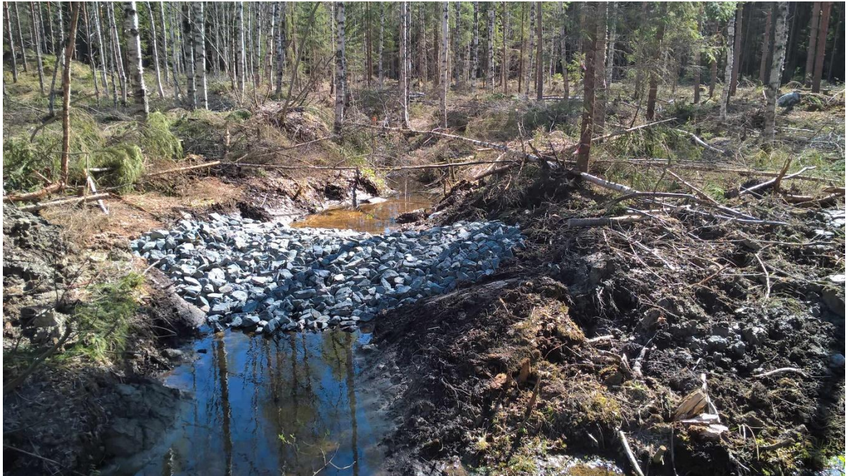
Kuva 8. Pelkkä suotopato ei ole riittävä työmaavesien käsittelykeino vaan pato tarvitsee lisäksi laskeutustilavuuden.
